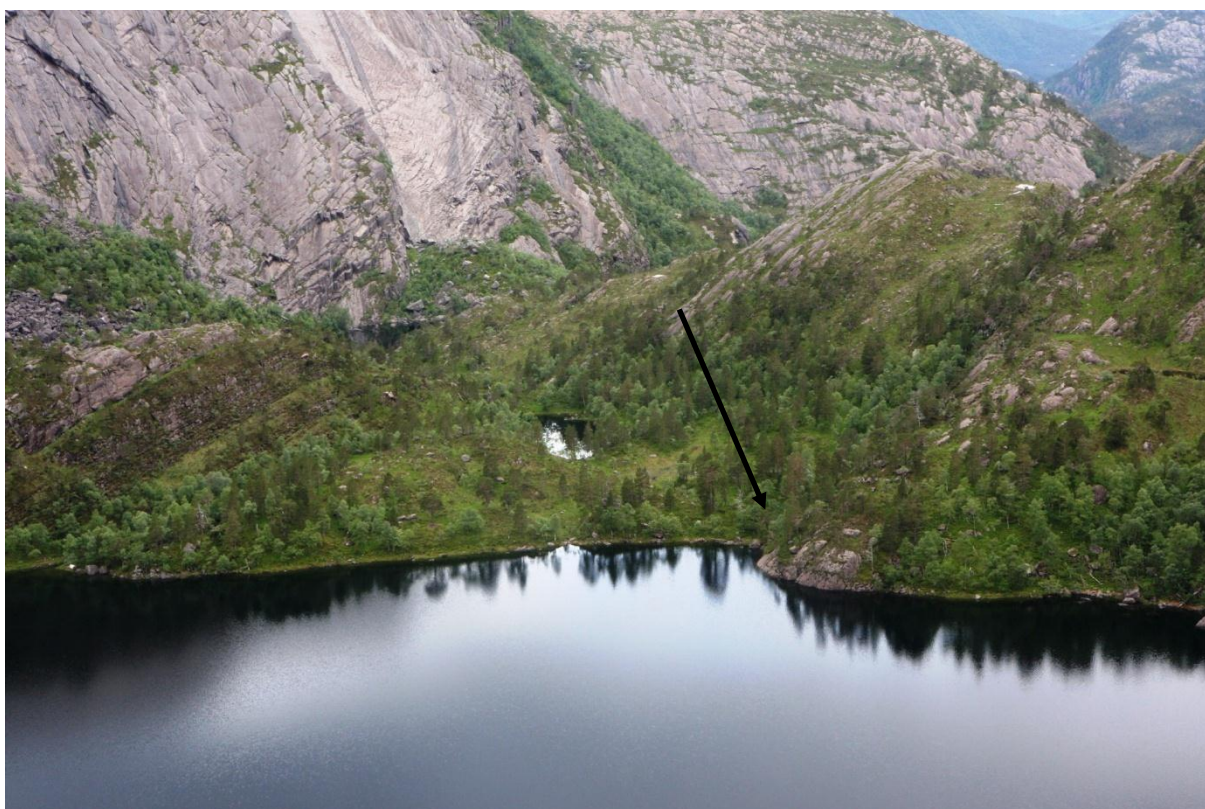
Bilete 6 Inntaket til Myrbærdalen kraftverk er markert med ei svart pil. Biletet er teke frå helikopter.
