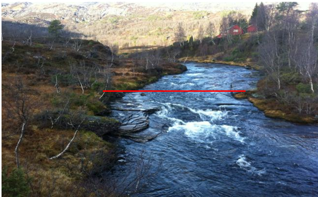
Figur 5 - 4: Raud stipla line indikerer plassering av terskel / damplate ca. 1,5 meter høg. Foto: Ole Reidar Flatby
