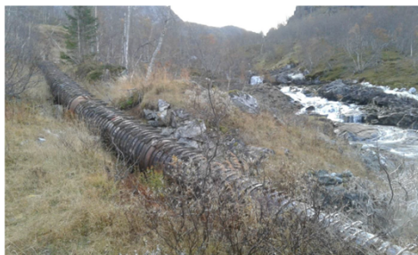
Fig. 31 Typisk bilete i dagens røyrgatetrasé. Ny røyrgate skal gravast ned.
