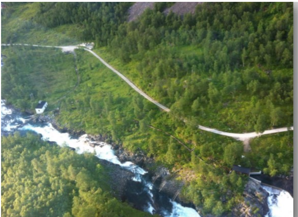
Eksisterende kraftstasjon og inntaksdam
