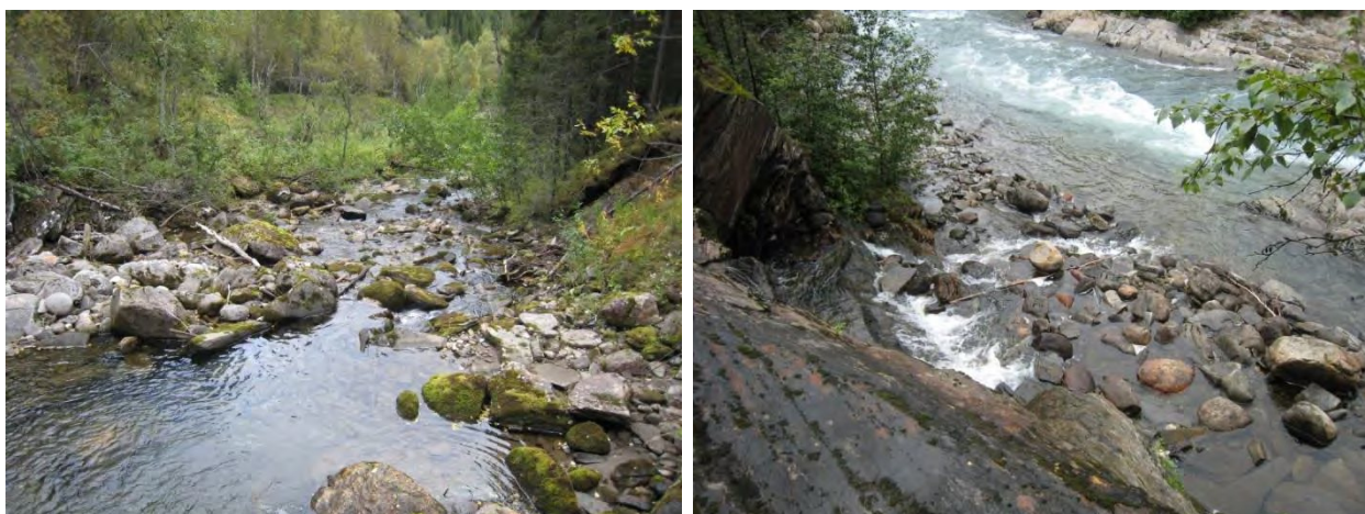
Figur 14. Bilder fra prosjektstrekningen. Venstre bilde viser sjørreretstrekning i Heståa nedstrøms inntaket. Høyre bilde viser utløpet av Troåga i Beiarelva.
