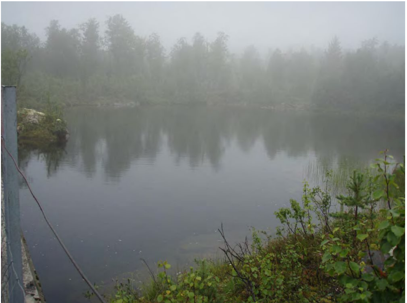
Figur 2 Eksisterende inntaksbasseng i Heståga
