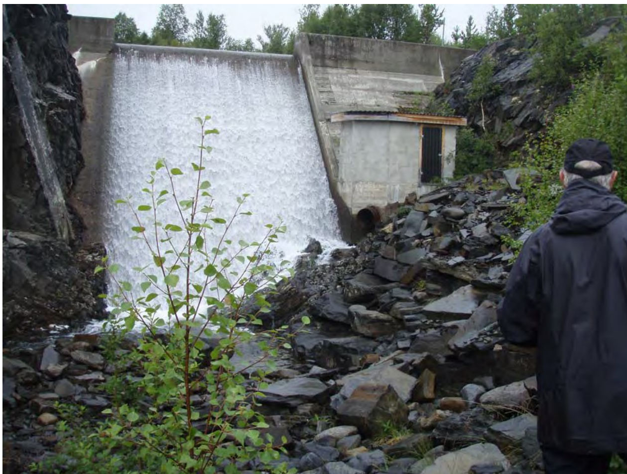
Figur 1 Eksisterende dam i Heståga kote 365 (overløp)
