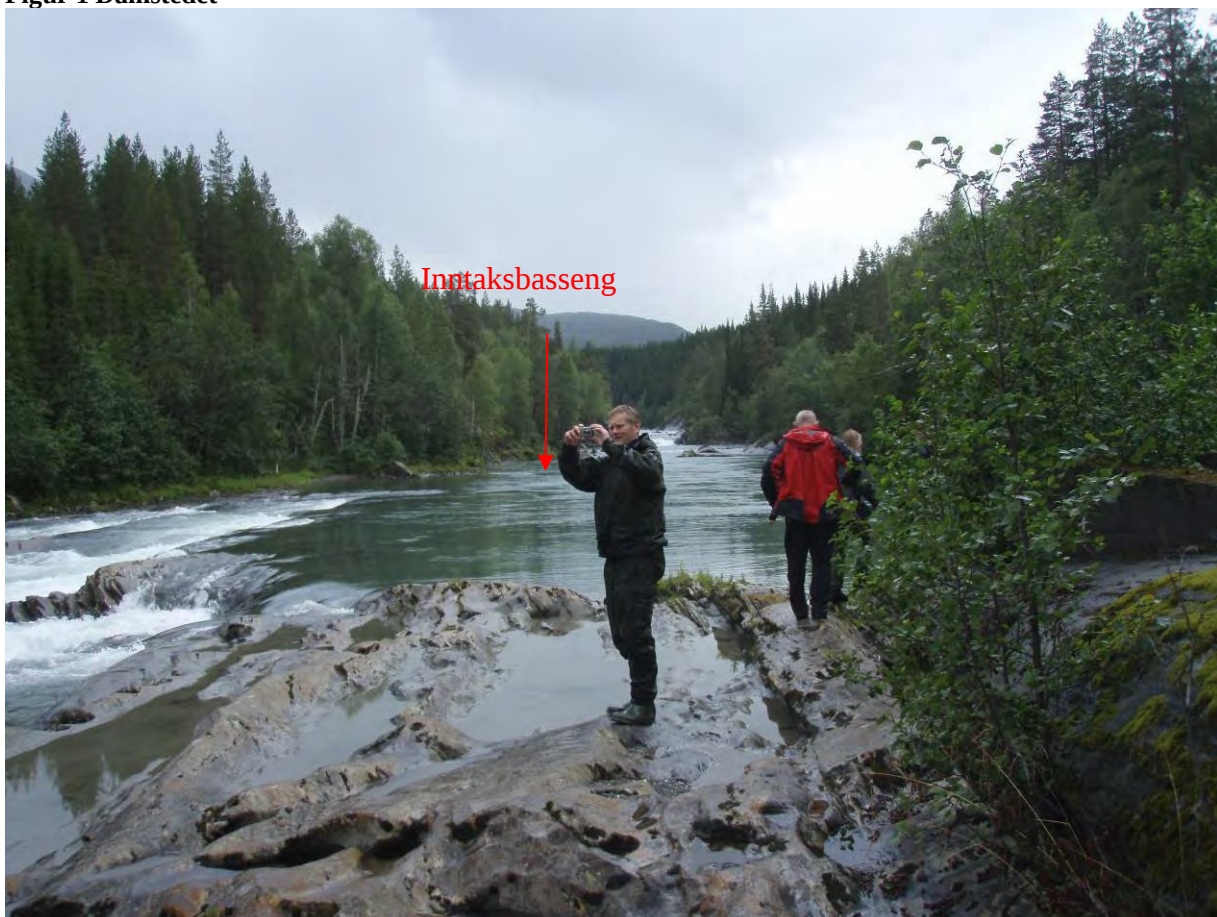
Figur 2 Bilde tatt fra damstedet og mot inntaksbassenget
