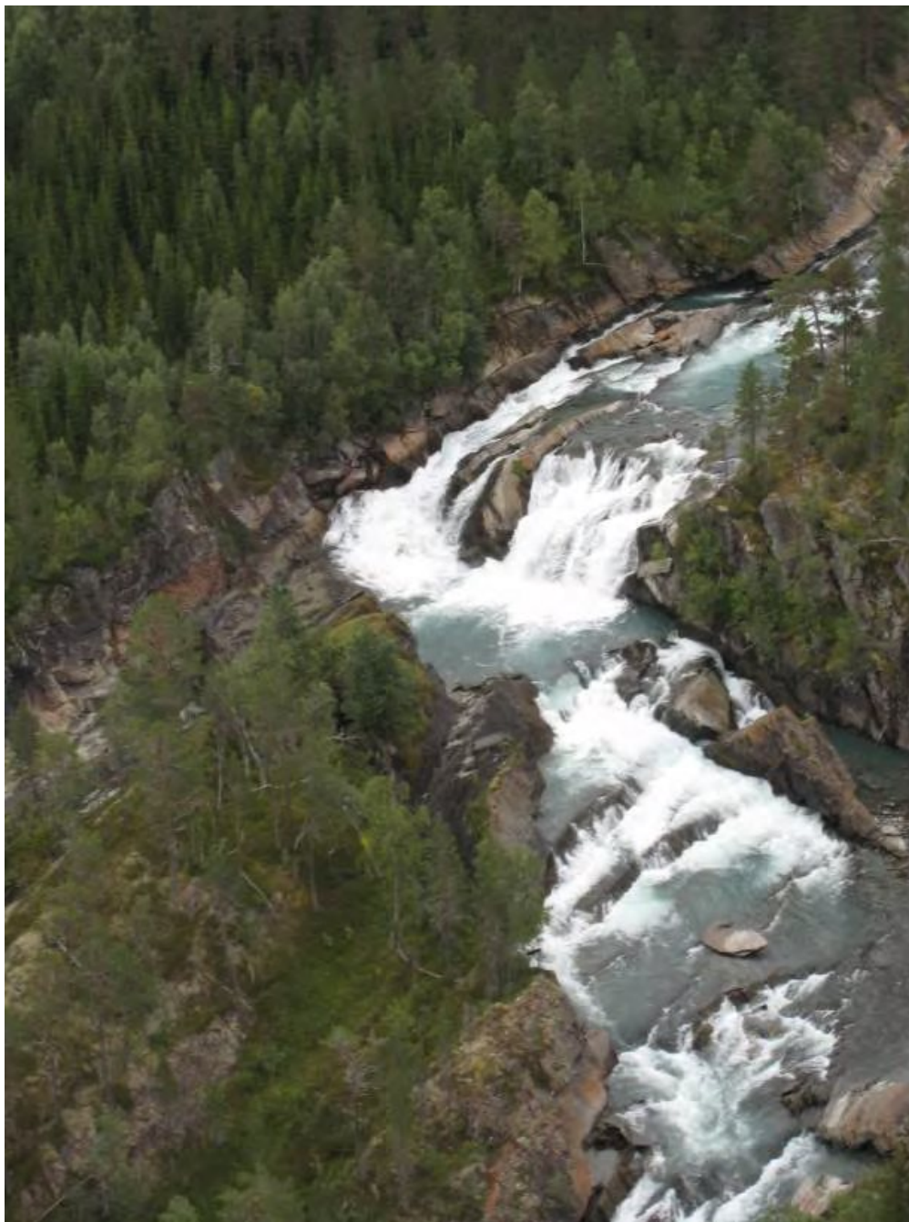
Høgforsen nedstrøms planlagt inntaksområde til Høgforsen kraftverk. Dato: 26. aug 2010. Estimert vannføring: 7,4 m 3 /s. (Foto: Per Ivar Bergan)
