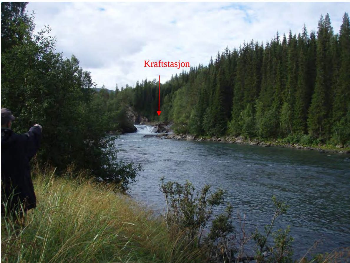
Figur 10 Beiarelva nedstrøms utløp kraftstasjon
