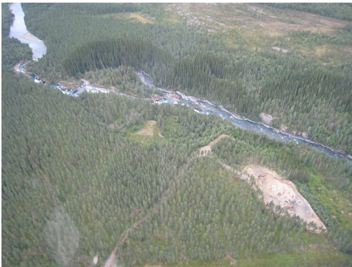
Beiarelva ved planlagt Bruforsen kraftverk. Dato: 26. august 2010. Beregnet vannføring på 7,4 m 3 /s (Foto: Per Ivar Bergan).
