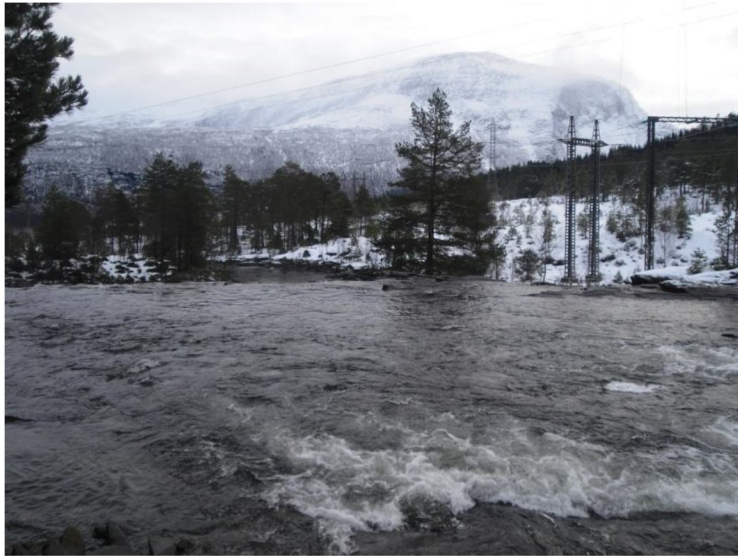
Mot inntaksplassering, røyrgate på høyre side av elva
