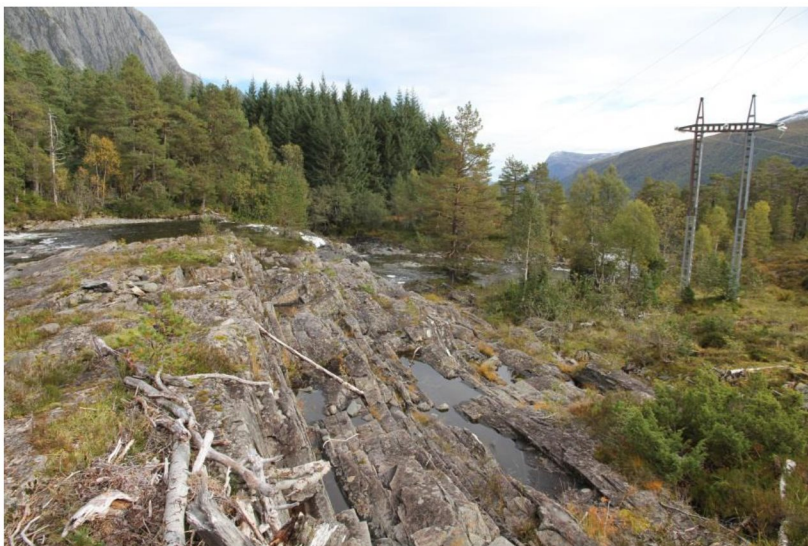
Inntaksområdet og nedstrøms damsted
