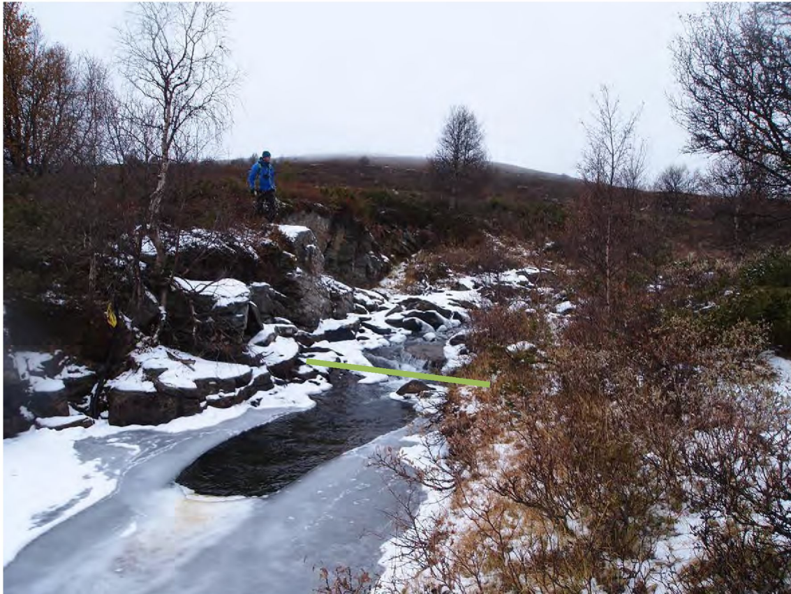
Fotografi 1: Inntaksdammen, sett fra nedstrøms. Terskel markert.
