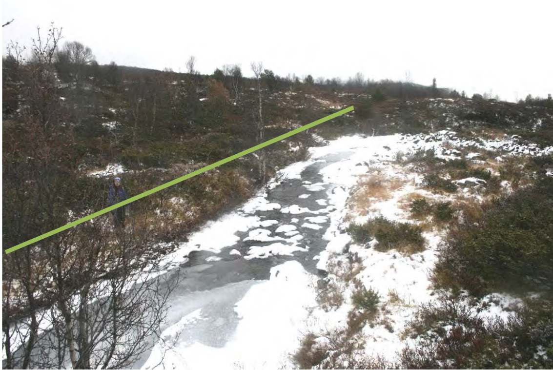
Fotografi 3: Rørgate fra inntaket
