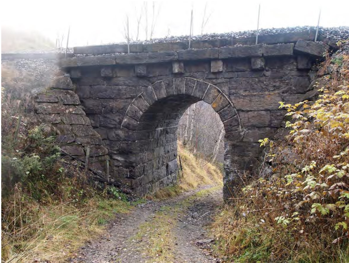
Fotografi 10: Undergang under jernbanelinje. Rørgaten vil gå igjennom denne.
