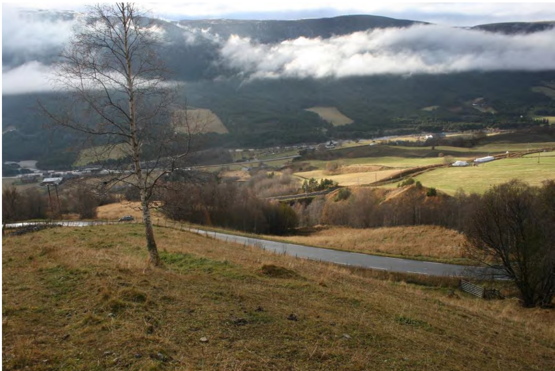
Fotografi 9: Rørgata må krysse veien. Jernbanelinja kan sees i bakgrunnen.
