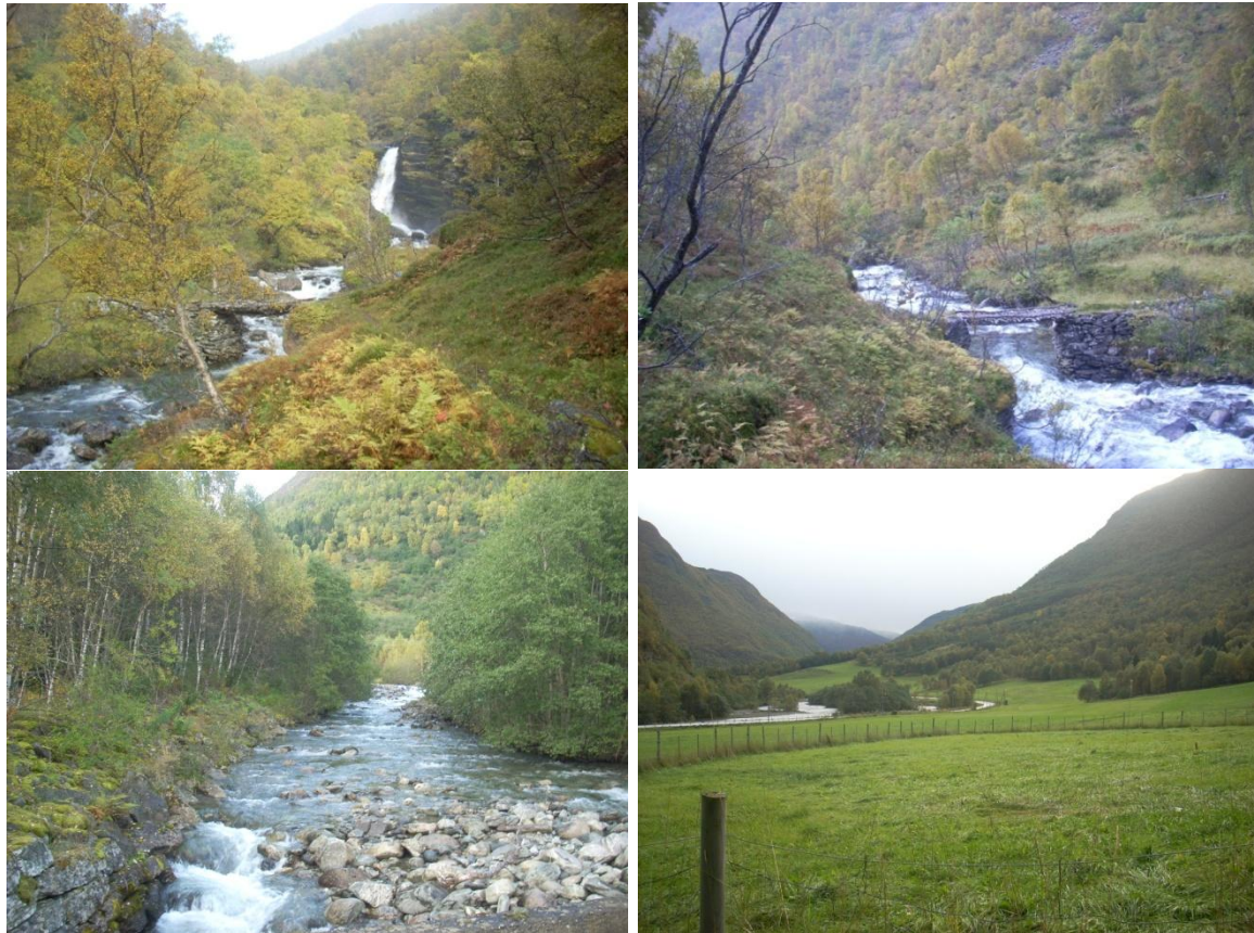
Figur 1: Øvre bilder viser sted for planlagte inntak kote 770 med gangbro over elva. Bildene under viser lokaliseringen av planlagt stasjonstomt med utløp (venstre), samt lokalitet for planlagt massedeponi (høyre).
