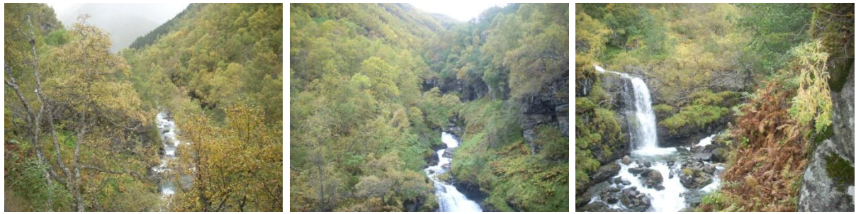
Over sees del av elva langs midtpartiet av utbygningsstrekningen, med samløp Tverrelva kote 585 til høyre.
