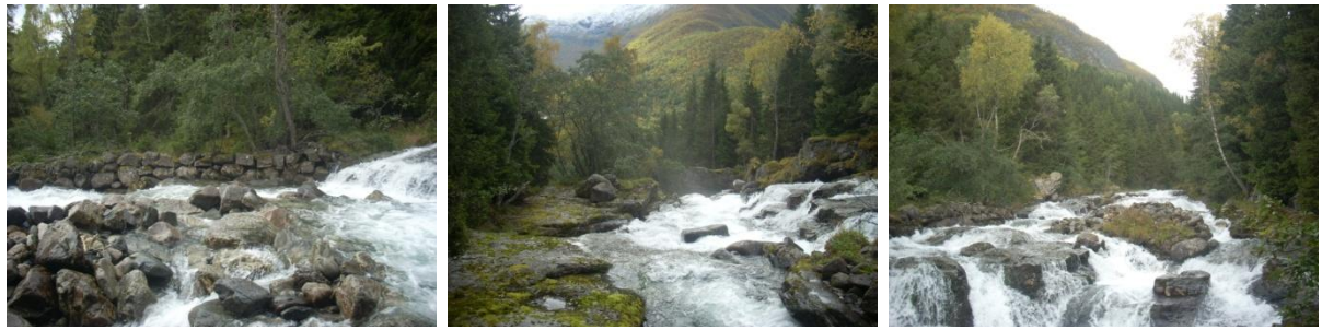
Bildene over viser eldre flomforbygning kote 490 (venstre), samt topp foss kote 480.
