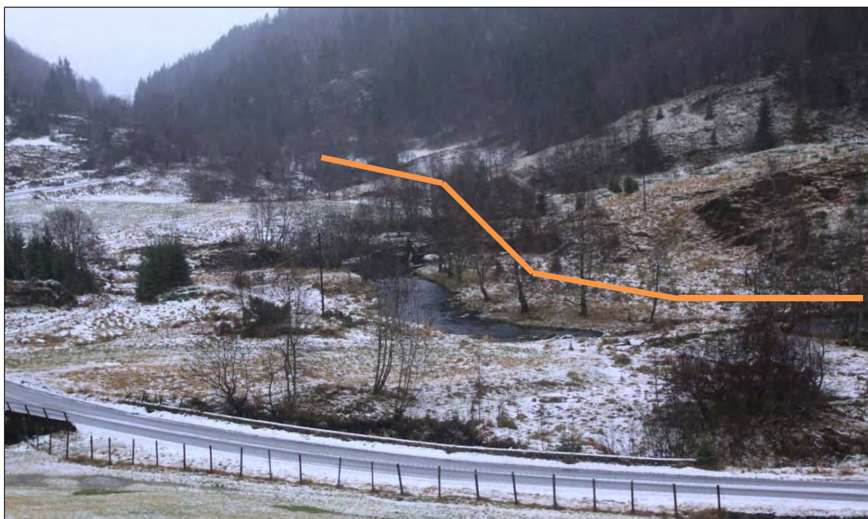
Figur 11. Rørgatetrasé mellom de to borhullene. Bildet er tatt ved Fengestad, omtrent midtveis mellom Øygardsvatnet og fjorden.
