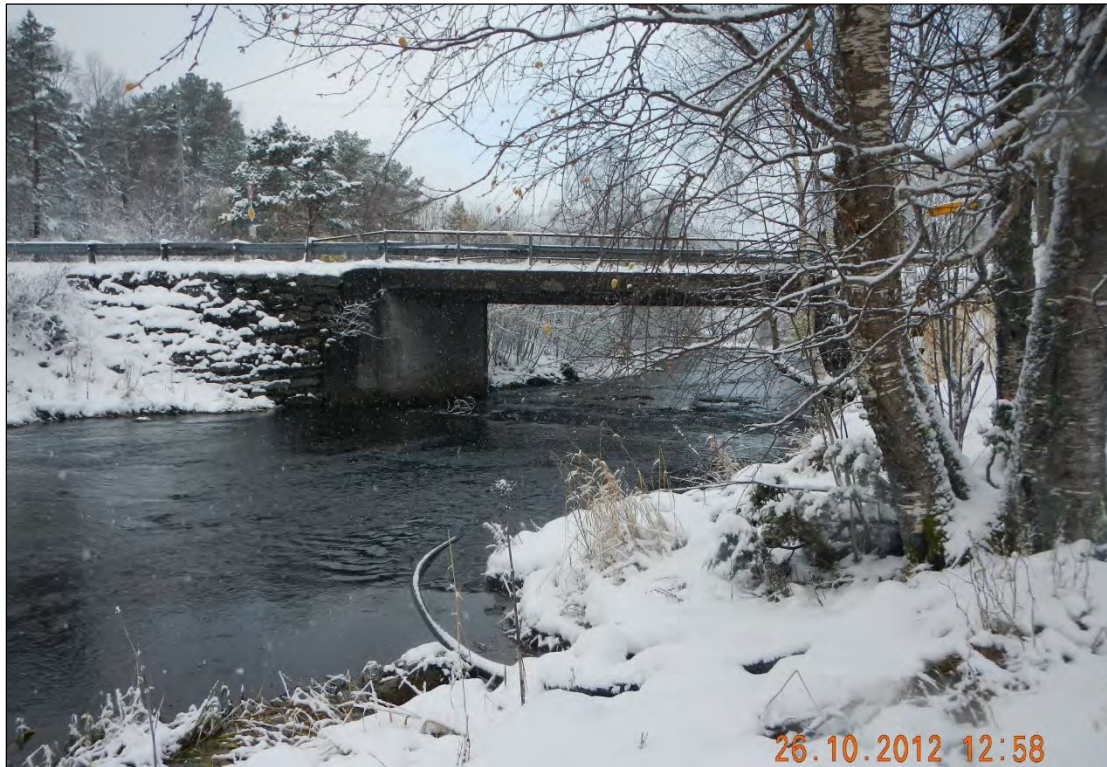
Fotografi 1: Bru mellom Karstadvannet og Øygardsvatnet. Høydeforskjellen mellom de to vannene er på omtrent 1,5 m.
