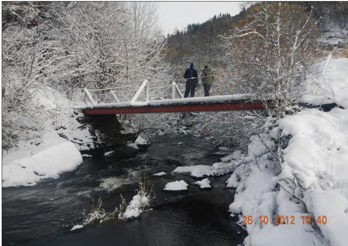
Fotografi 3: Inntaksdammens plassering. Vannføring ca. 0,9 \text{ m}^3/\text{s} .
