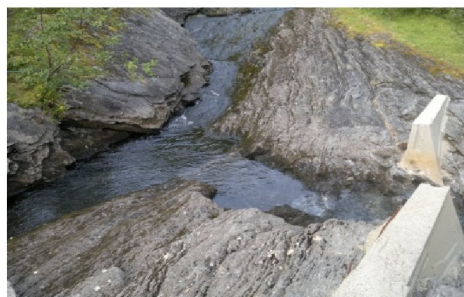
Bildet tatt 15.8.2011 Vannmengde 5-10 l/s.
