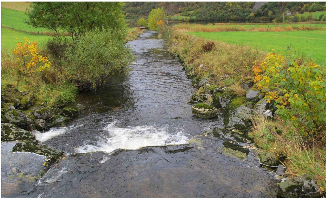
Figur 13. Biletet viser elvestrekning i den nedste delen av Stølselva. Her ser ein tydeleg det som Hellen mfl. (2000) nemnde, at kantane er plastra, og at det er steinsette tersklar i elvebotnen (Foto; Oddvar Olsen © 06.10.2012).
