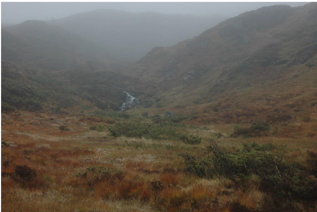
Figur 6. Inntak for overføring frå Stølselva er under synleg del, vassføring 50 l/s
