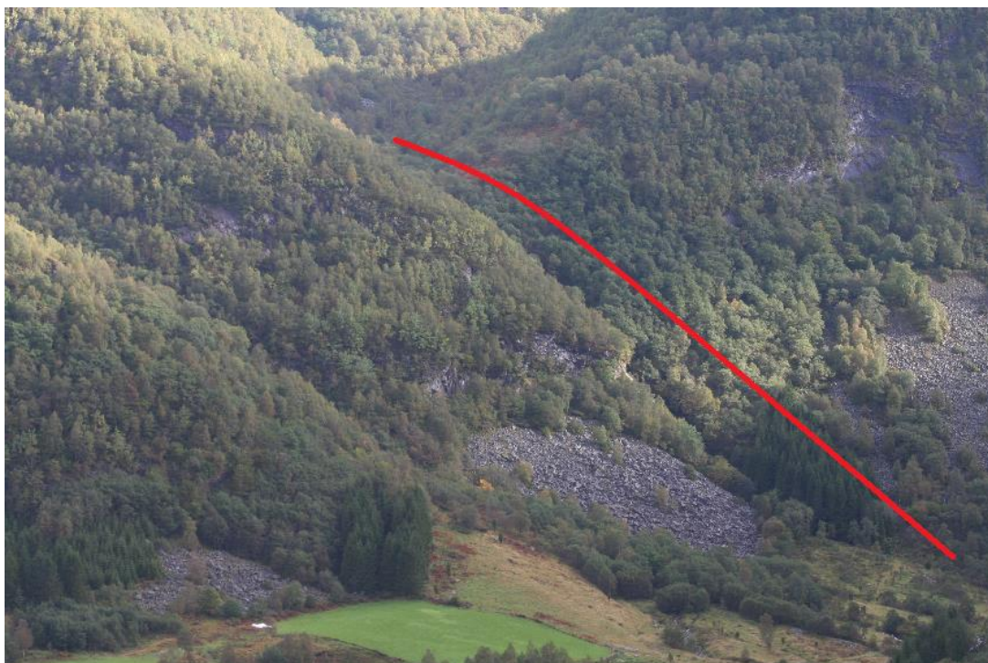
Figur 13. Rørgatas beliggenhet i terrenget.
