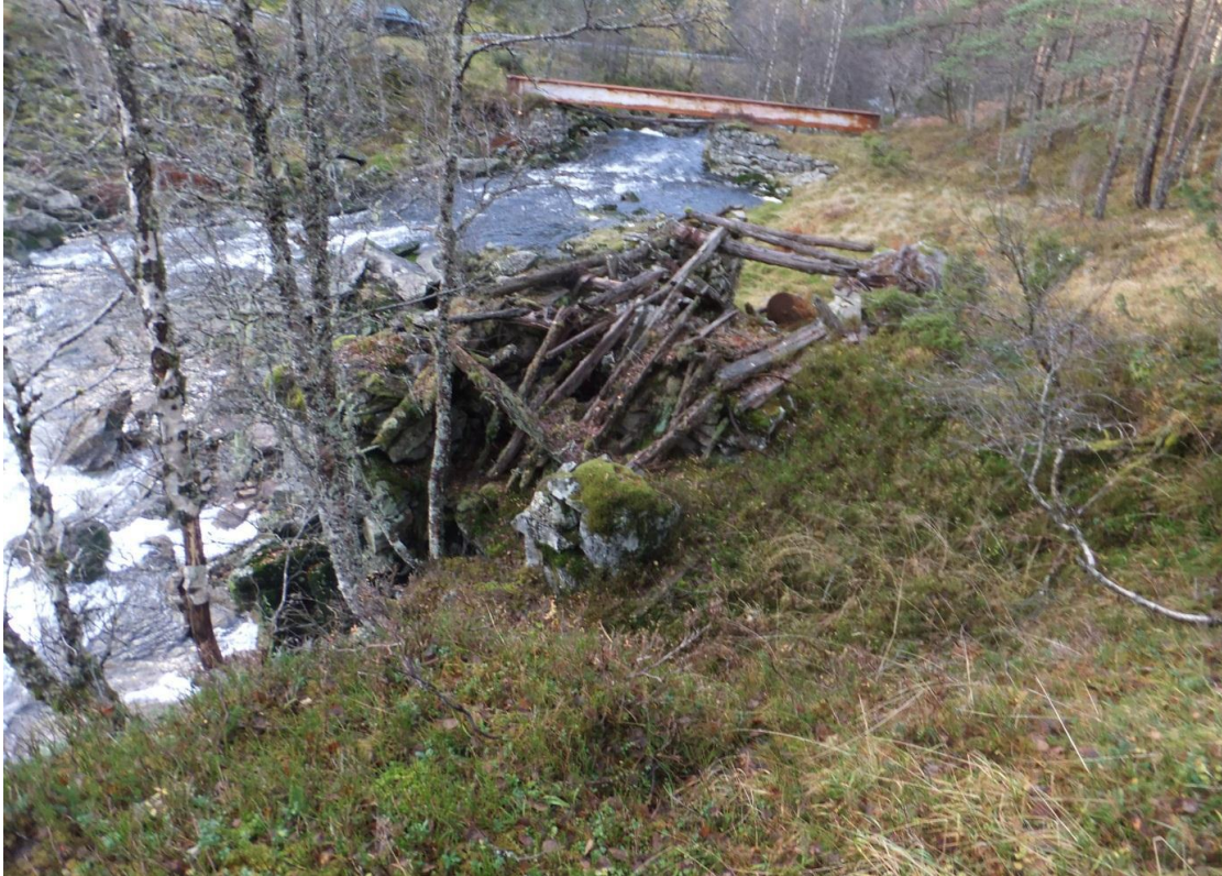
Bilde 5: Gamal sag, bru over elva. Adkomstveg til inntak er tenkt kryssa elva over brua.
