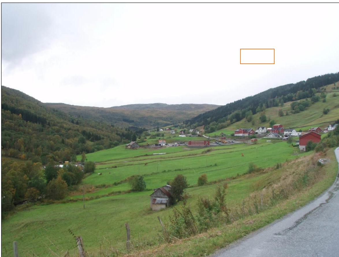
Bilde 12. Øvstedalen oppstrøms for inntaket. Statnetts brakkerigg midt i bildet.
