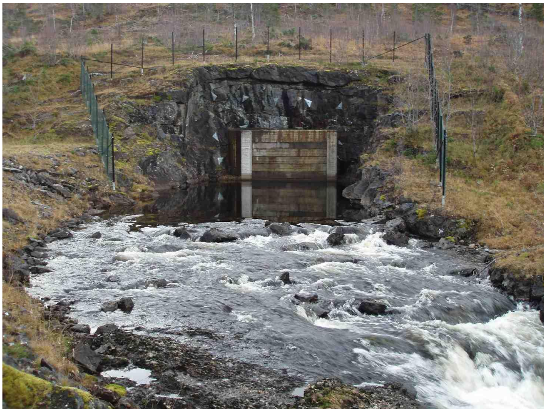
Bilde 1: Utløpet av overføringstunnelen fra Krossåa.
