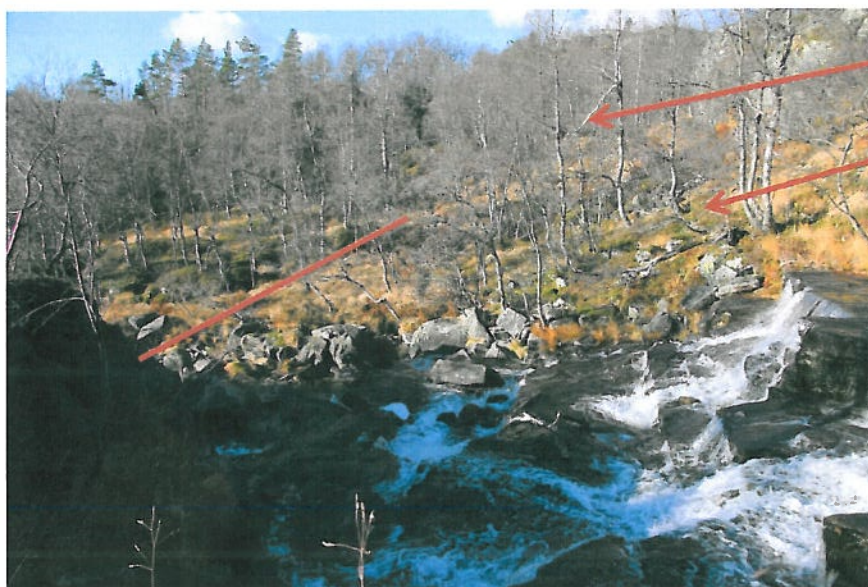
Figur 2-14 Inntak kote 515, sett ovenfra
