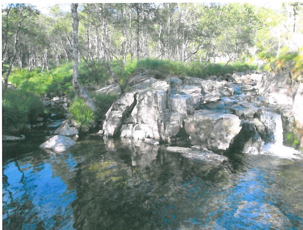
Ca 50 meter nedstrøms inntak 1, vannføring ca 0,3 \text{ m}^3/\text{sek}
