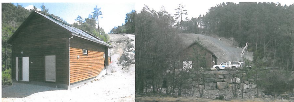
Figur 2-17 Eksempel på kraftstasjon
