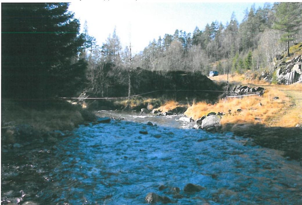
Inntaksområdet ved inntak 2 kote 370
