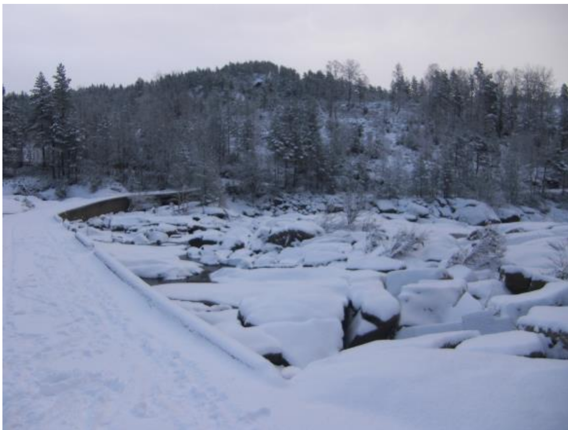
FIGUR 6: VISER MOT INNTAKSOMRÅDET FOR KRAFTVERKET HVOR DET BLIR ANLAGT KANAL INN TIL TUNNEL.
