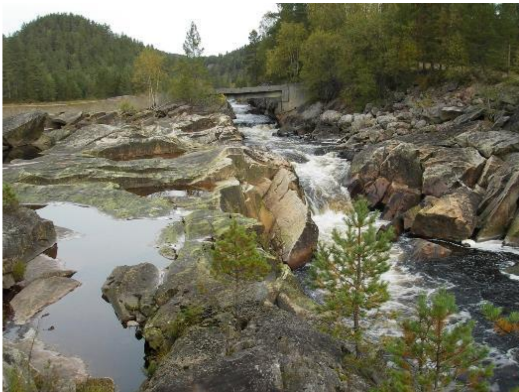
FIGUR 21: BILDET VISER BROEN VED INNTAKET. 17.9.2009.
