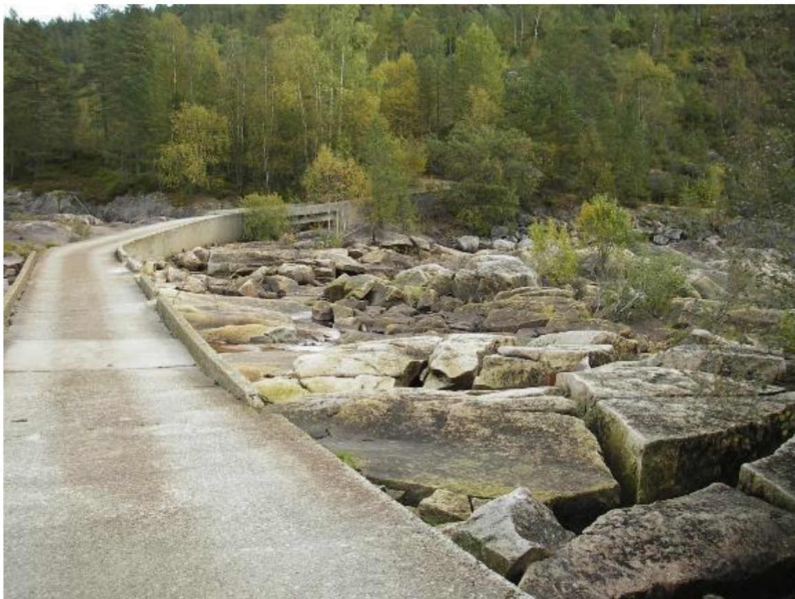
FIGUR 22: BILDET VISER BROEN VED INNTAKSOMRÅDET SOM GÅR OVER KVINA. 17.9.2009.
