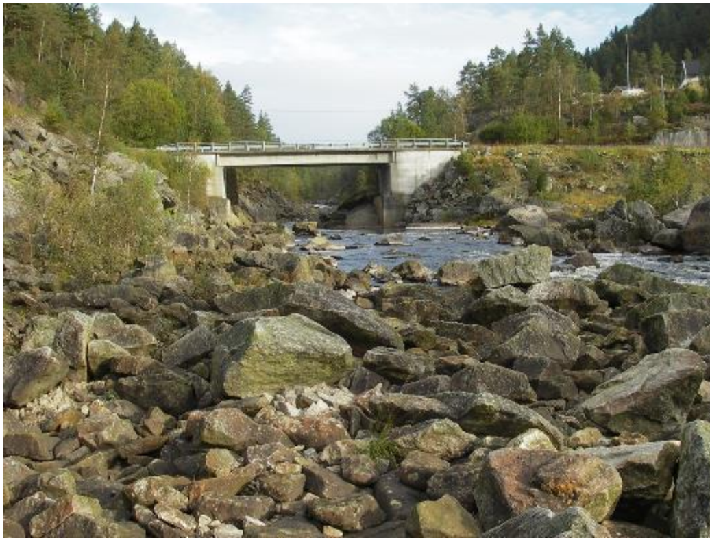
FIGUR 20: BILDET TATT MOT BROEN VED STAKKELAND. 17.9.2009.
