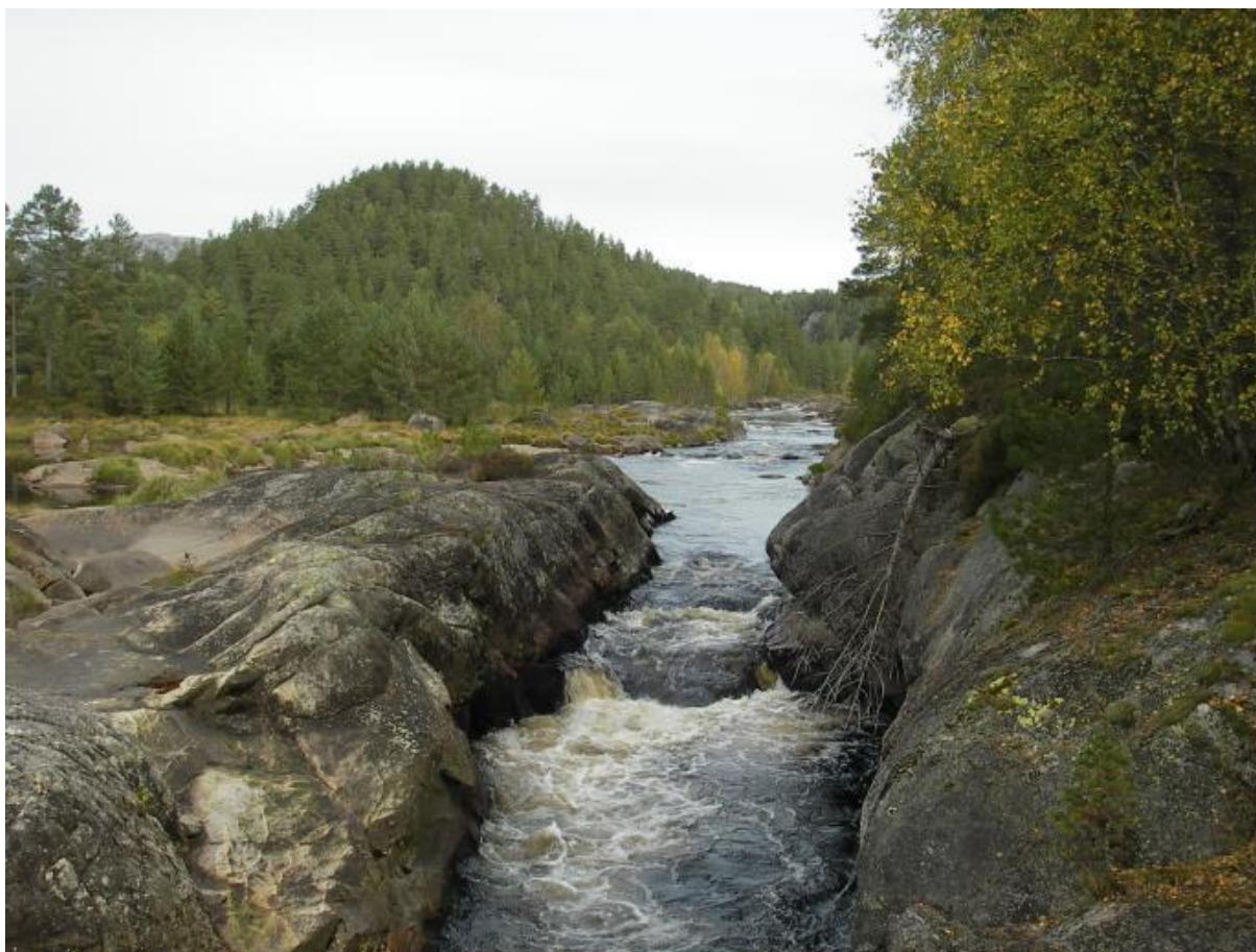
FIGUR 7: BILDET VISER HOVEDLØPET FOR KRAFTVERKET HVOR ARRANGEMENT FOR MINSTEVANNFØRING BLR.
