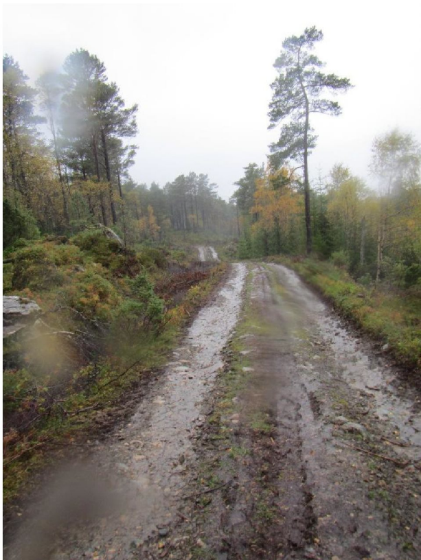
Eksisterende skogsvei. Rørtrasee midt i strekning (+160)
