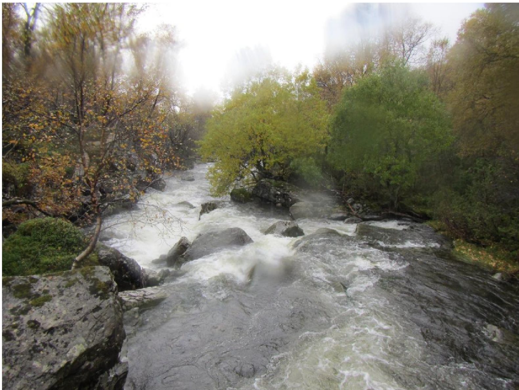
Umiddelbart nedenfor inntak (+310)
