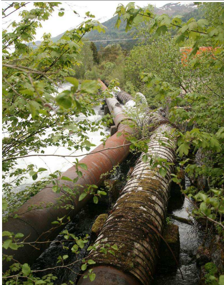
Figur 3-5 dei to gamle rørgatene skal rivast og erstattast med ei ny.
