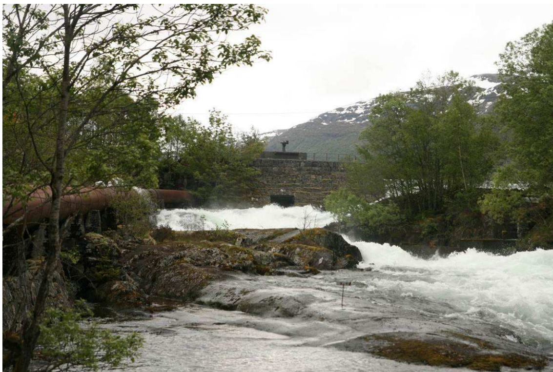
Figur 3-2 Delar av den gamle dammen. Kviafossen til høgre for dammen. Fisketrappa går opp mellom bjørkene i høgre bildekant.
