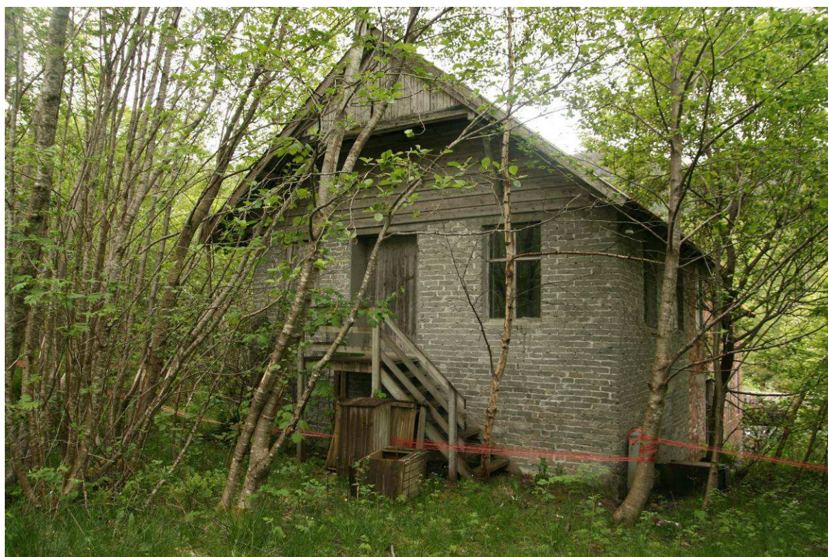
Figur 3-4 Bygning som er planlagt sett i stand og brukt til klubbhus for den lokale sportsfiseforeininga.
