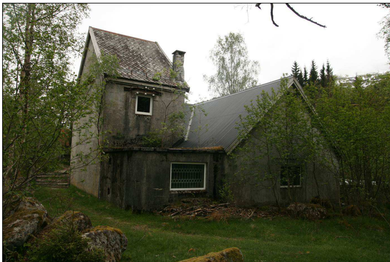
Figur 2-9 Den gamle kraftstasjonen slik den framstår i dag. Generator/turbin i rommet i høgre del av bygningen, kontor, lagerrom, brytarrom etc. i høgbygget i venstre del. Traforommet vert i rommet med lågaste takhøg.
