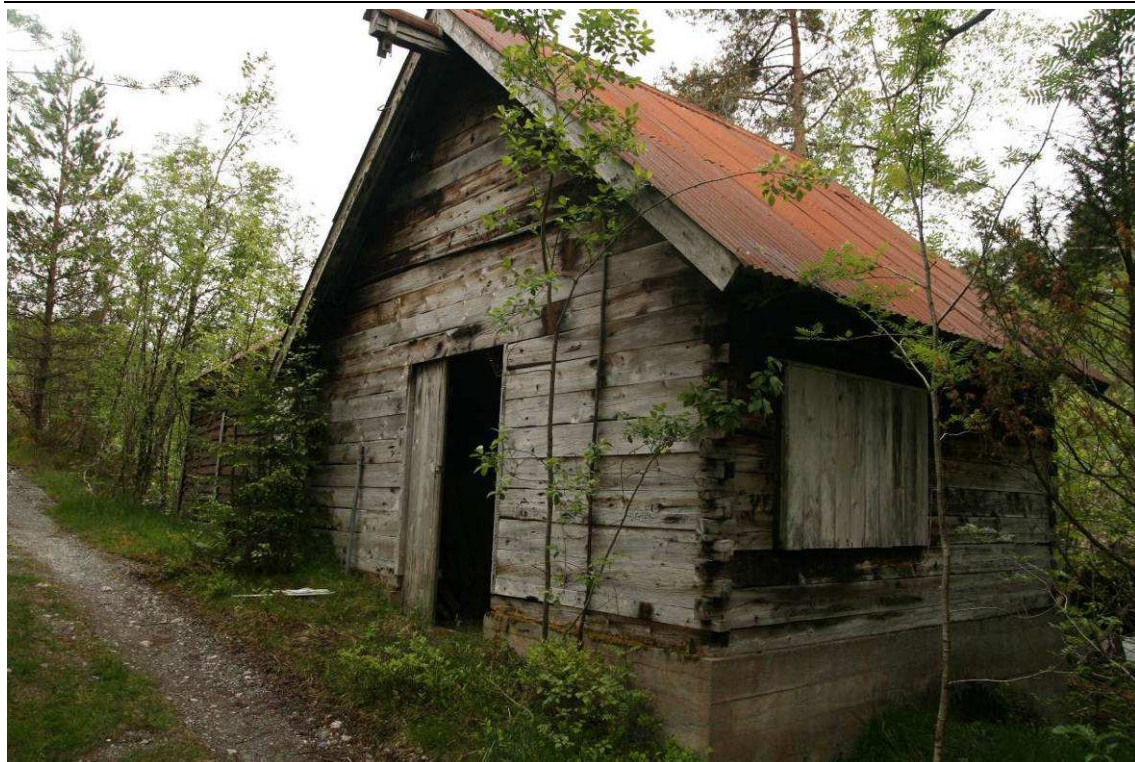
Figur 3-3 Gamal smie som truleg var bygd i samband med kraftverket.
