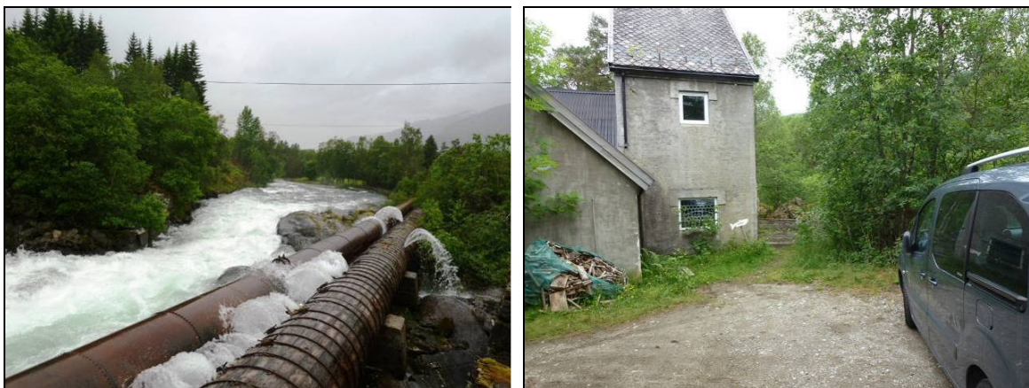
Figur 3. Eksisterende vannvei i dagen (t.v.). Foto: Ole Kristian Spikkeland. Eksisterende kraftstasjon (t.h.). Foto: Per G. Ihlen.
