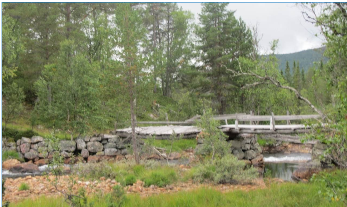
Figur 13. Eksisterende gangbro. Erstattes med kjørbare bro for atkomst til kraftstasjonen.
