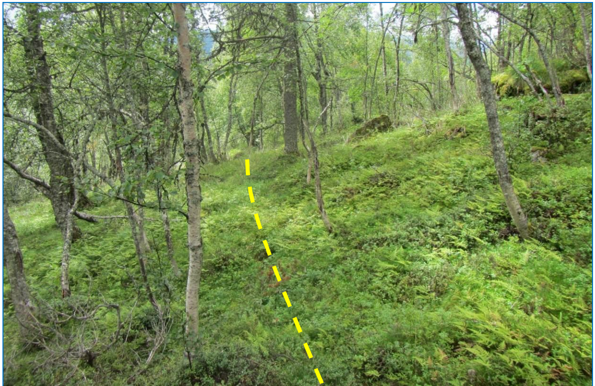
Figur 9. Rørtrasé øvre del går igjennom lett vegetasjon i terreng med sidehelning og tynt løsmasselag.
