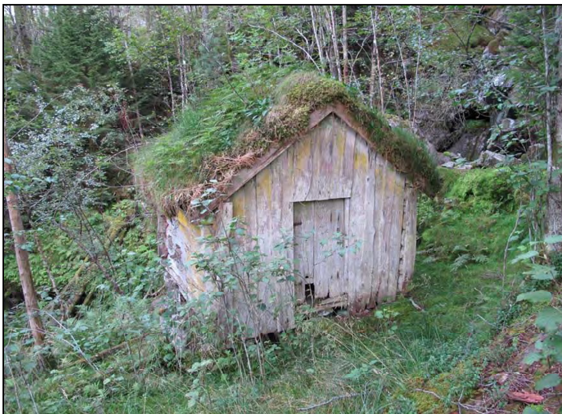
Figur 8.1. Kvernhuset som ligger ved Sabakkeelva. Kvernhuset er fra tidlig 1800 tallet og er godt vedlikeholdt (foto: Ole K. Larsen).
