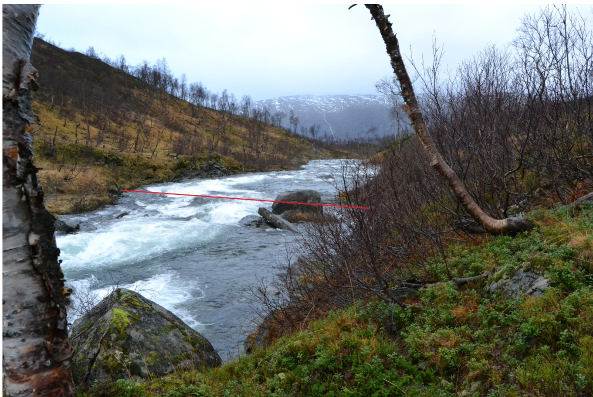
Figur 5. Bilde av inntaksområdet. Plassering av dammen markert med rød strek
