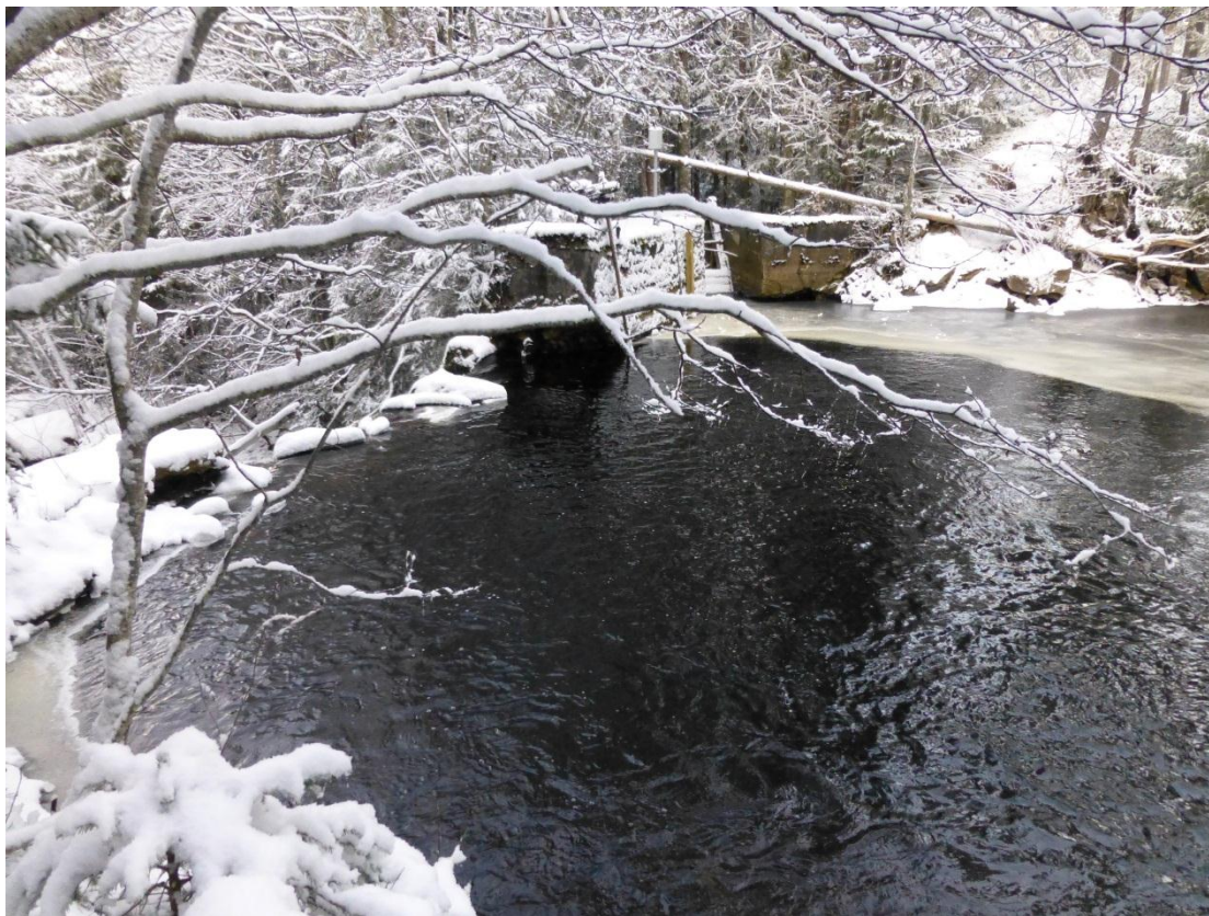
Bilde 4: Viser dam for gammel kraftstasjon, oppstrøms ny kraftstasjon
