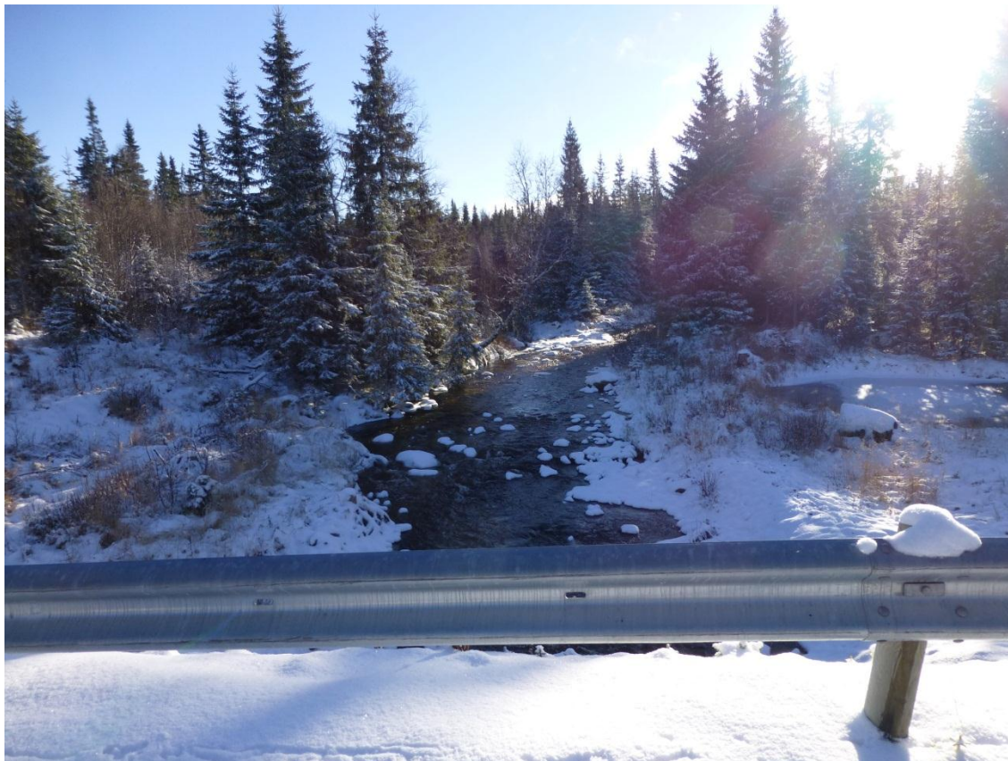
Bilde 18: Viser Deia på sydsiden av bru ved dam/inntak. Branndam til høyre.
