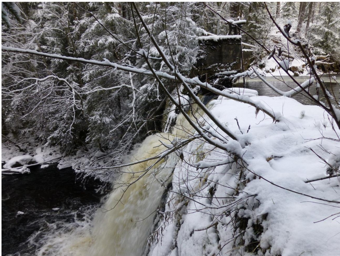
Bilde 5: Viser overløp dam for den gamle kraftstasjon.
