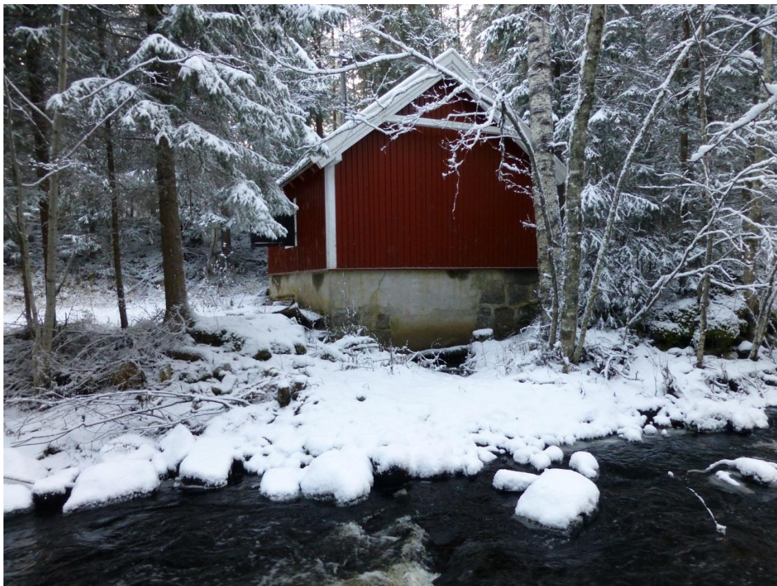
Bile 3: Viser gammel kraftstasjon i umiddelbar nærhet til ny kraftstasjon
