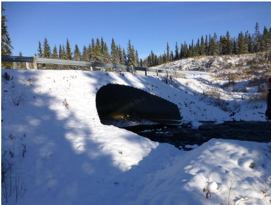
Bilde 14: Viser sydsiden av bru ved dam/inntak.
