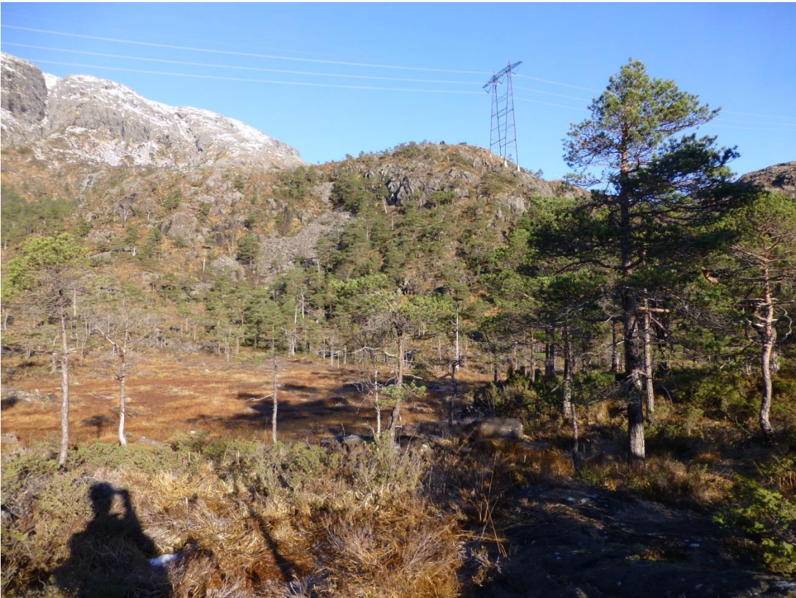
Bilde 9: Viser terreng opp mot dam/inntak.
