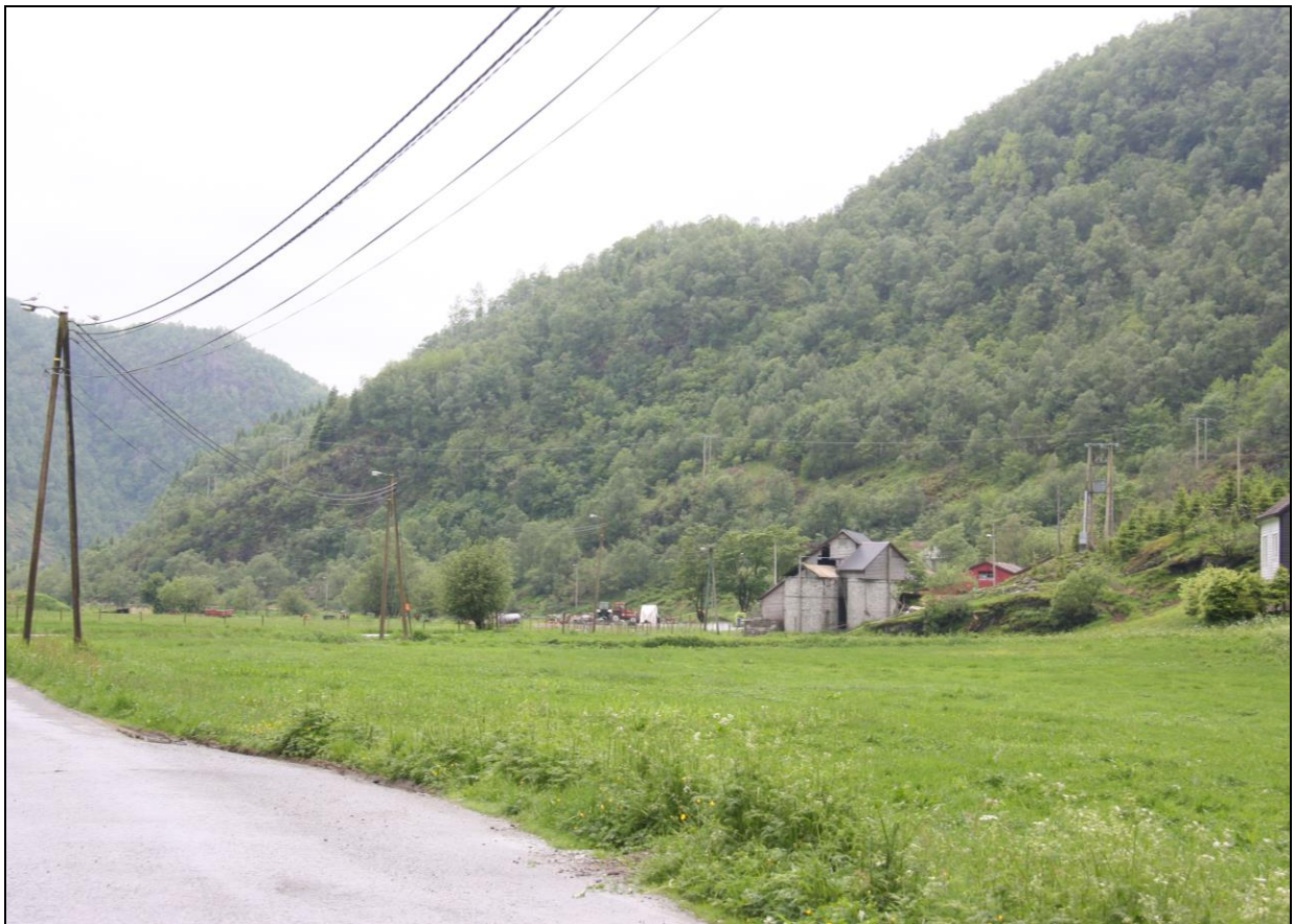
Figur 24. Sædalen kraftverk tilknyttes 22 kV-nettet via en ca. 0,5 km jordkabel til høyspentledningen som sees helt til høyre i bildet. Foto: Ole Kristian Spikkeland.
