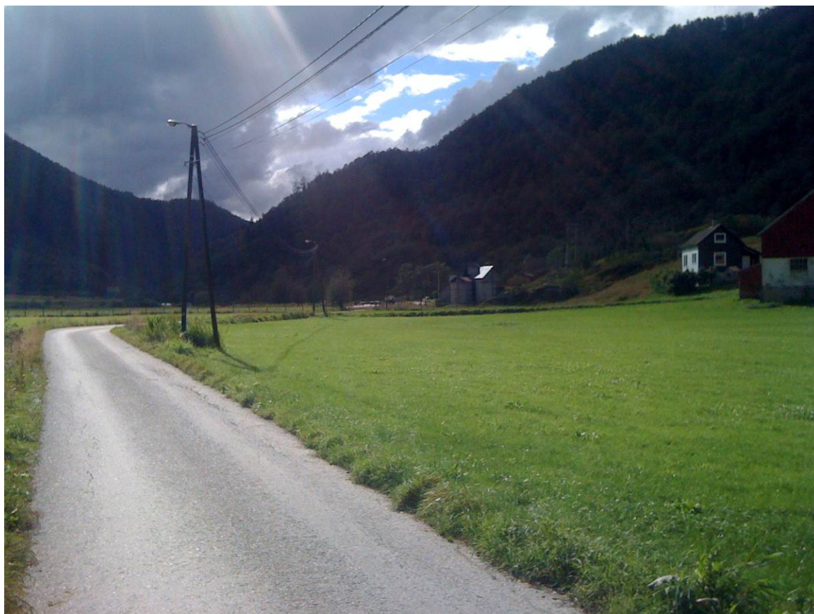
Bilde 6.2 22 kV kraftlinje langs veien
