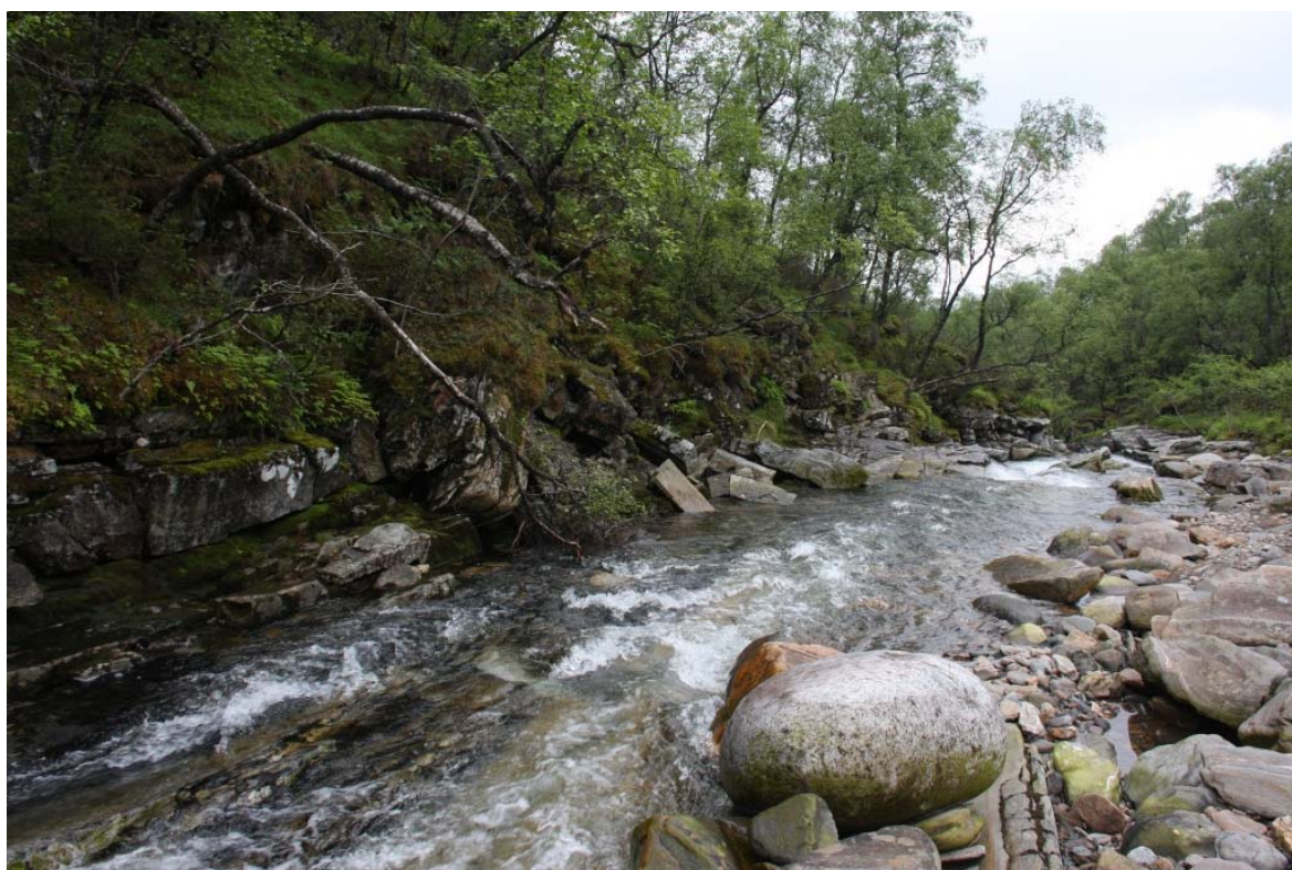
Bilde 2.2 Inntak iog demning sett nedover ca. kote 250 m.o.h
