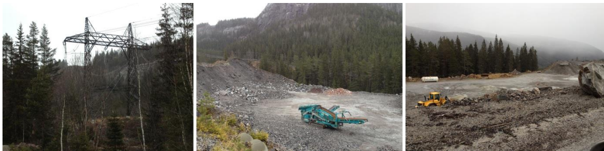
Figur 3: Bileta syner store inngrep med 420 kV nettleidning og massetak like nedanfor tiltaksområdet.
