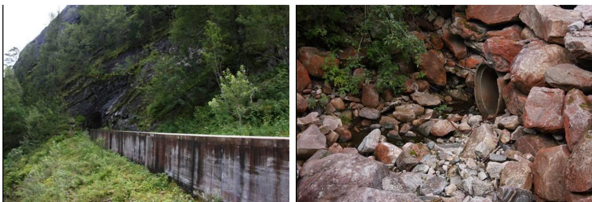
Figur 12. Ved planlagt kraftstasjon, kote 596 m, ledes Håvestøylsåne inn i tunnel mot Brokke kraftverk ( t.v. ). Elveløpet like nedstrøms er i dag helt tørrlagt ( t.h. ). Foto: Ole Kristian Spikkeland.
