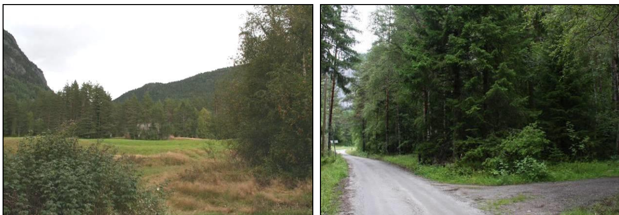
Figur 31. Nettilknytningen for Straume kraftverk vil skje i form av nedgravd jordkabel langs veikant-areal og dyrket mark med grasproduksjon. Foto: Ole Kristian Spikkeland.
