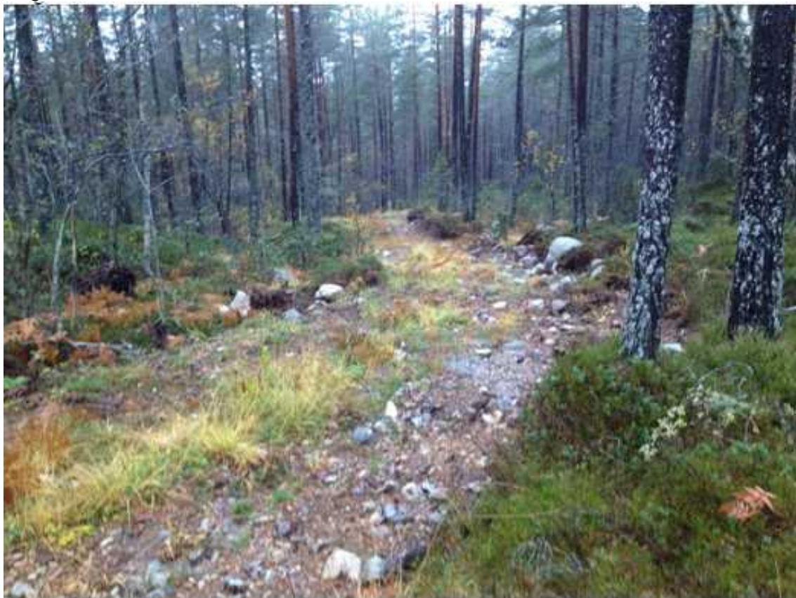
Første del av rørtrase, ovenfor kraftverk.
