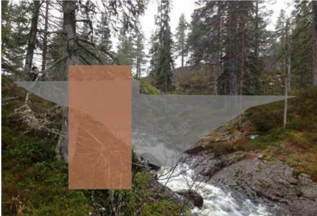
Utløp Svartetjørn, dam markert med grått, inntak med brunt.
