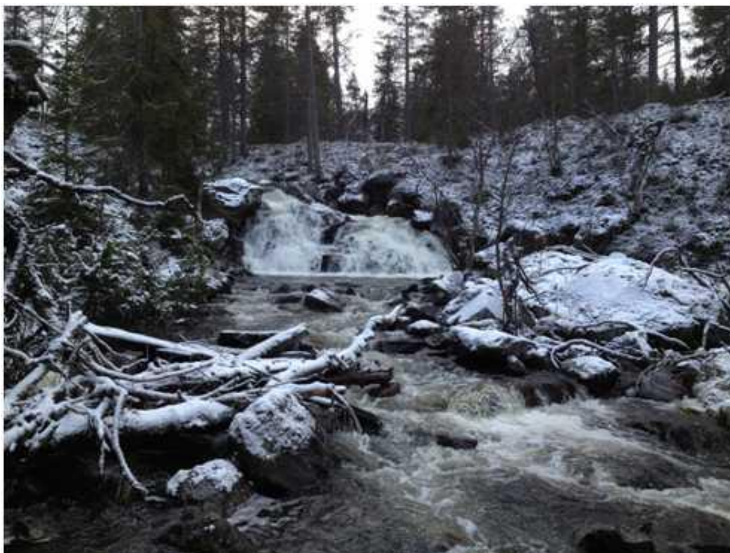
Kvernåni ca 300 m nedstrøms inntak, vannføring ca 800 l/s.
