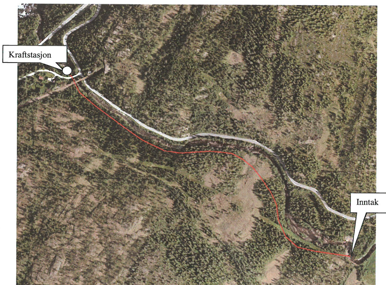
Figur 2 Flyfoto over området. Rørtraseen er skissert inn på bildet, fra inntakdam høyre billedkant til utløp venstre billedkant.
