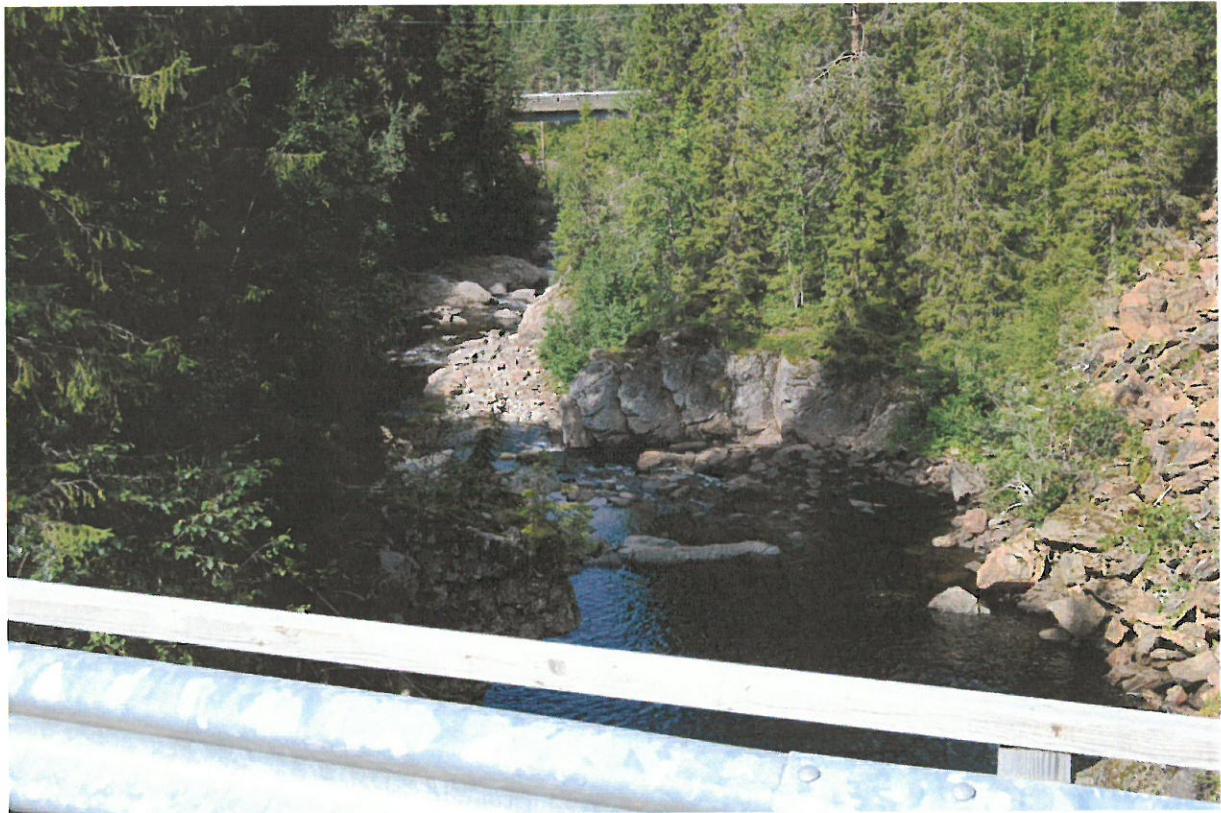
Figur 23 Brekkvasselva og jernbanebrua sett fra dagens E6. Hverken rørgate eller kraftstasjon vil være synlig fra E6, og som trafikant skal man være observant for i det hele tatt å registrere vassdraget ved passering.
