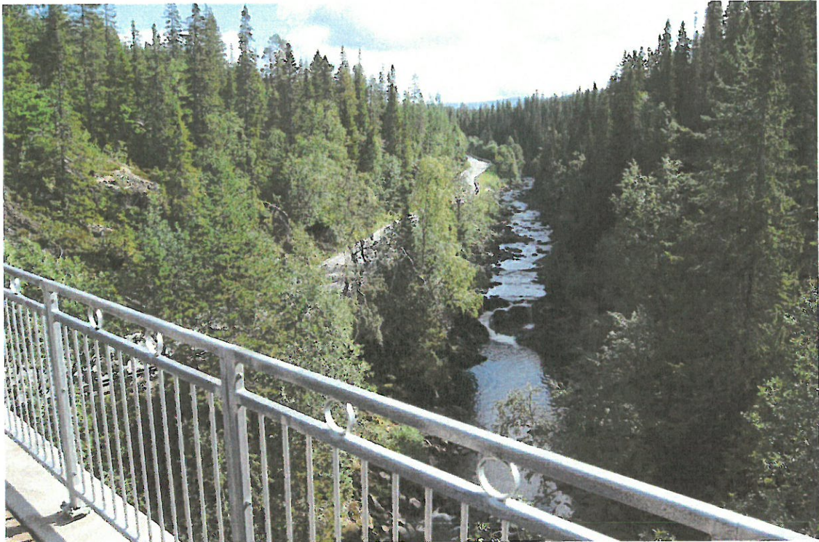
Bilde 19 Brekkvasselva oppstrøms jernbanebro.
