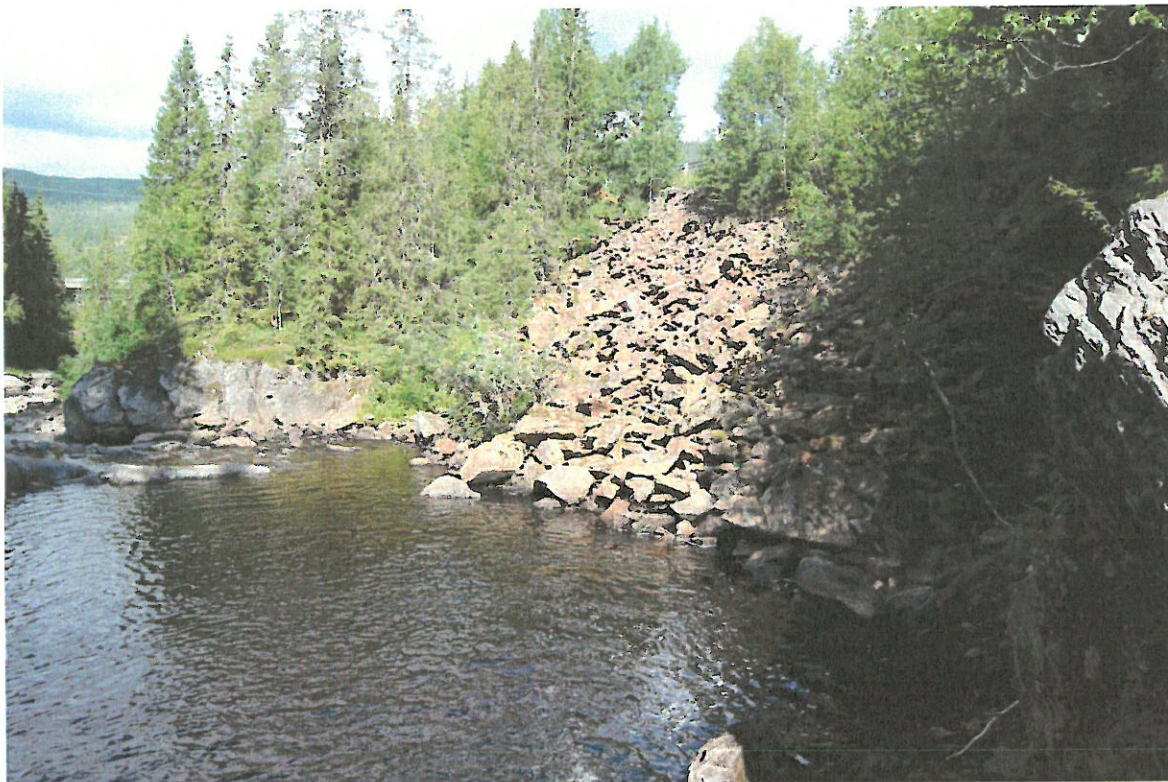
Bilde 15 Steinfylling for RV773. Kulpen ligger like nedstrøms jernbanebro.
