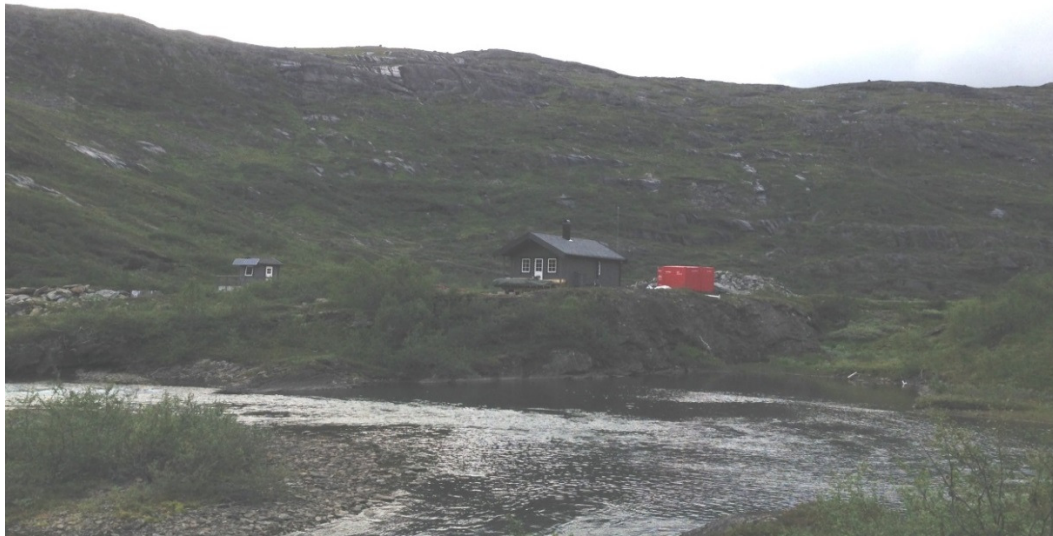
Figur 5 Den nye damvokterbua, i bakgrunn til venstre lukehuset (Foto Geir Magnor Olsen).
