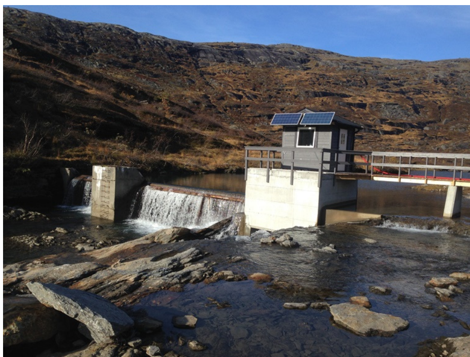
Figur 4 Eksisterende dam med luker/lukehus som ble bygget i 2013 ved utløpet av Kvannvatnet. (Foto Geir Magnor Olsen.)
