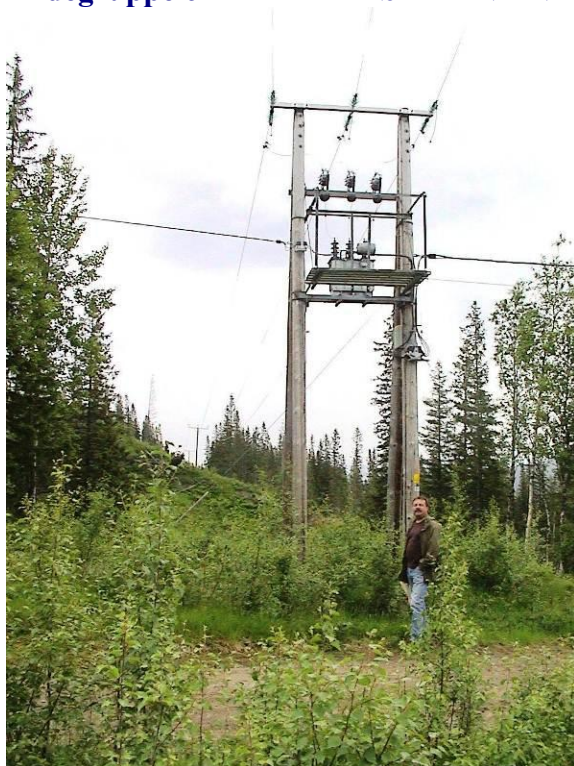
Bilde 6.1 Tilkopling til 22 kV kraftlinje
