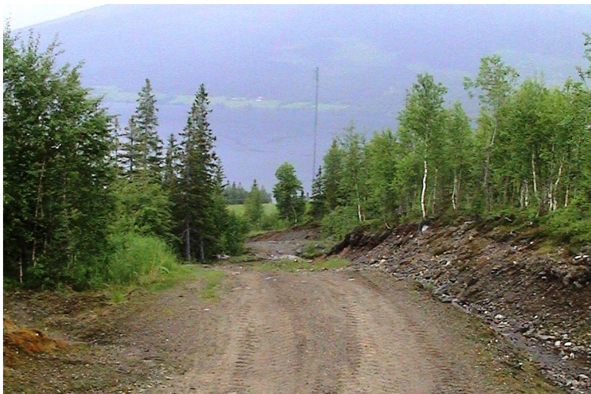
Bilde 1.2 Eksisterende vei opp til inntak
