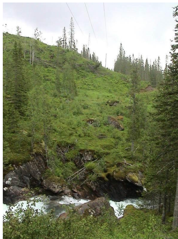
Bilde 3.6 22 kV kryssing ca kote 75 moh
