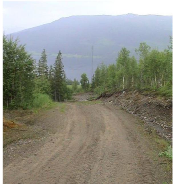
Figur 9 – Parti fra rørgatetraséen kote 180
