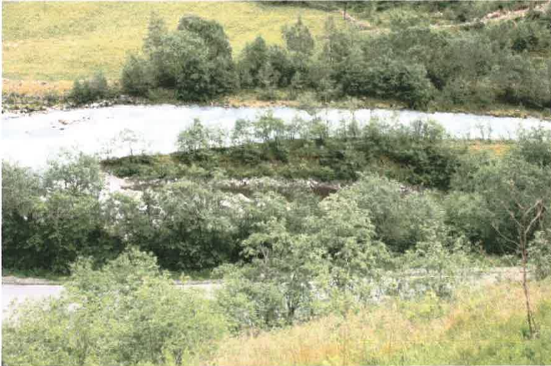
Fig. 3 Frå stasjonsområdet. Kraftverket er tenkt plassert heilt til høgre i biletetbiletet, der kanalen endar. Ein skimtar også opptekne elvemassar bak skogen midt i biletet, mellom kanalen og egen. På andre sida elva, midt på bildet skimtar ein så vidt ei høgspenmast, hovudforsyningslinja (24kV) gjennom dalen.
