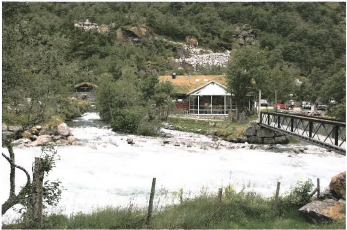
Fig. 1. Oversikt over området der inntaket er planlagt. I området framføre busken i elveløpet rett føre samløpet med Storelva. Det nedgravne inntakskammeret kjem i området mellom brukaret (gangbrua) og servicebygget. Kanalen for tilleggsvatn må byggast ilag med plastringa som allereie eksisterer på oppstraums side langs Storelva.
