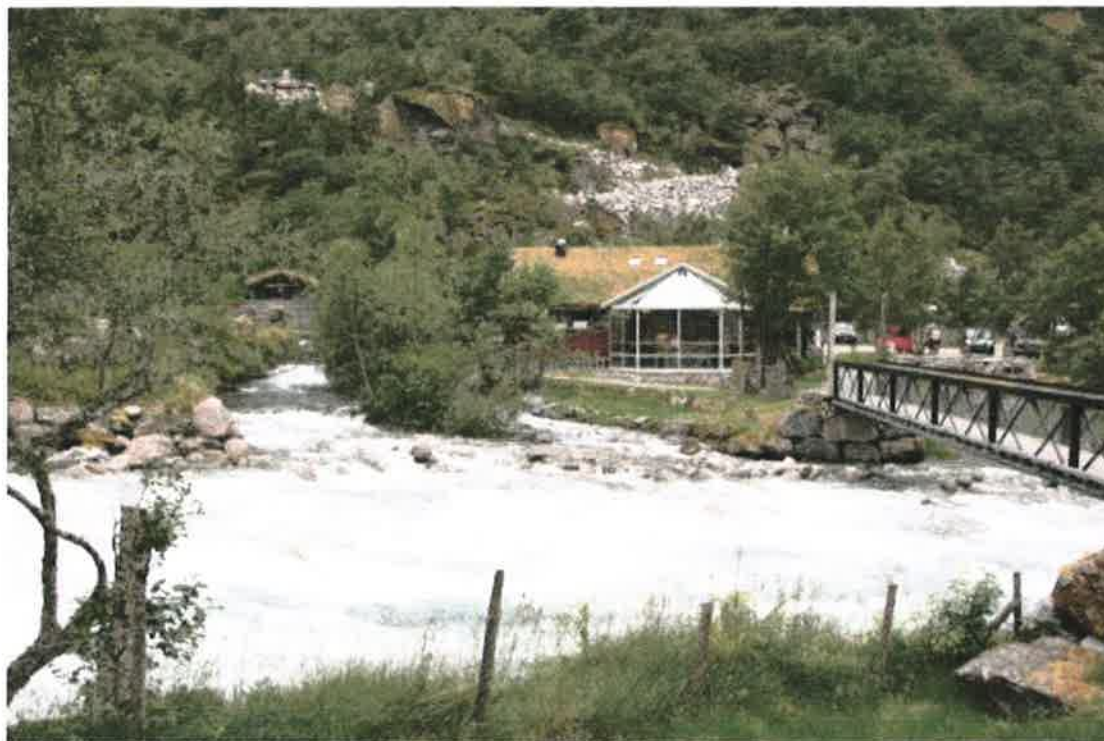
Fig. 5 Oversikt over området der inntaket er planlagt. I området framføre busken i elveløpet rett føre samløpet med Storelva. Det nedgravne inntakskammeret kjem i området mellom brukaret (gangbrua) og servicebygget. Kanalen for tilleggsvatn må byggast ilag med plastringa som allereie eksisterer på oppstrams side langs Storelva.
