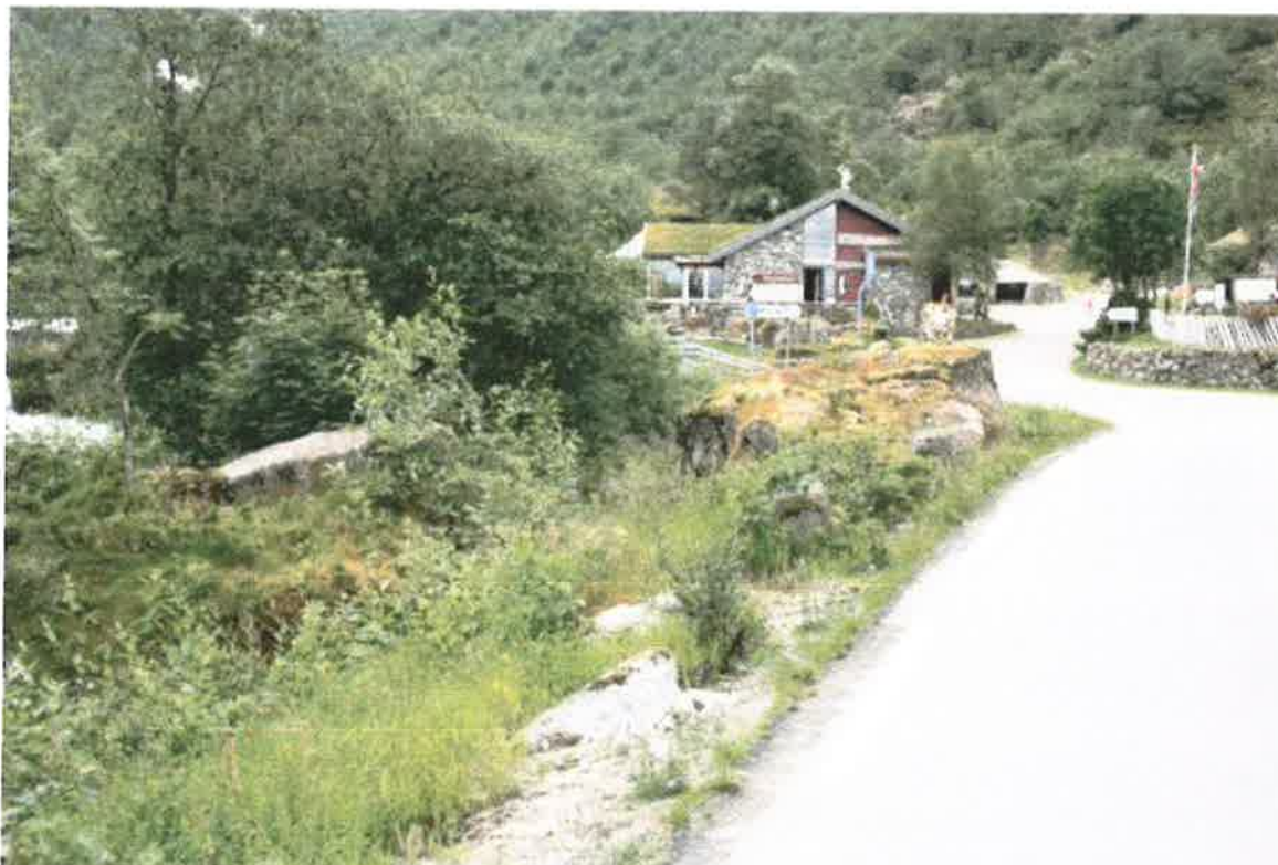
Fig. 8 Frå det flatare partiet av vassvegen fram mot inntaksområdet, på venstre side av servicebygget i bakgrunnen. Røyrgatetrasén vil krysse vegen i området kring den store steinblokka som ligg inn mot vegskuldra, frå venstre til høgre side.
