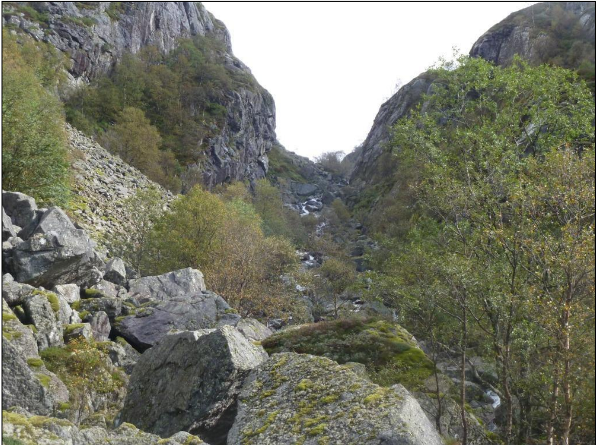
FIGUR 6: INNTAKET PLANLEGGES I DET LILLE GJELET BAKERST I BILDET.
