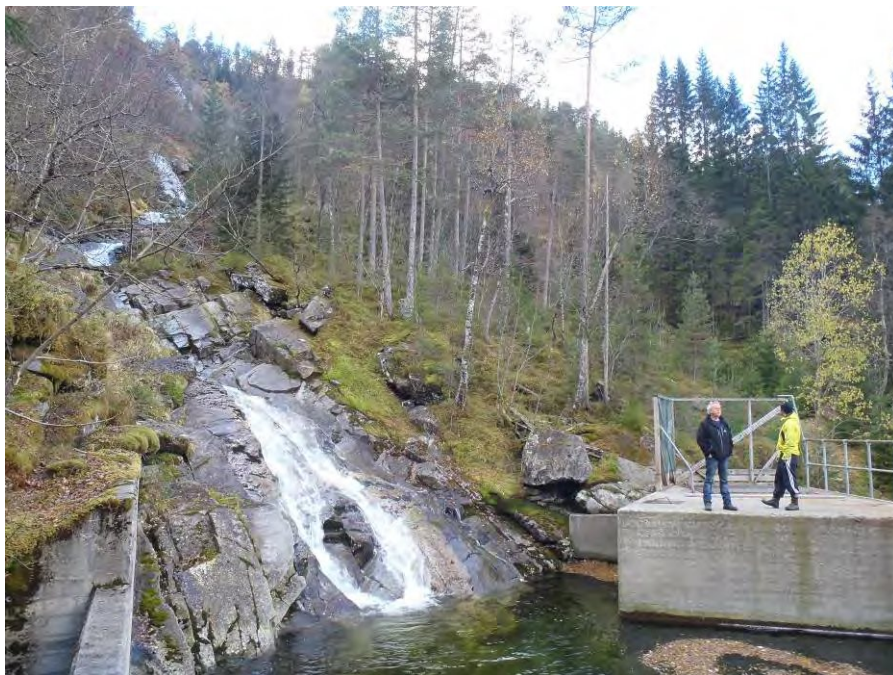
Foto liten vassføring 16.10.12. Ved utløpet frå kraftstasjonen, bekkeinntak til BKK i framgrunnen. Vassføring estimert til mellom 50 og 100 l/s.
