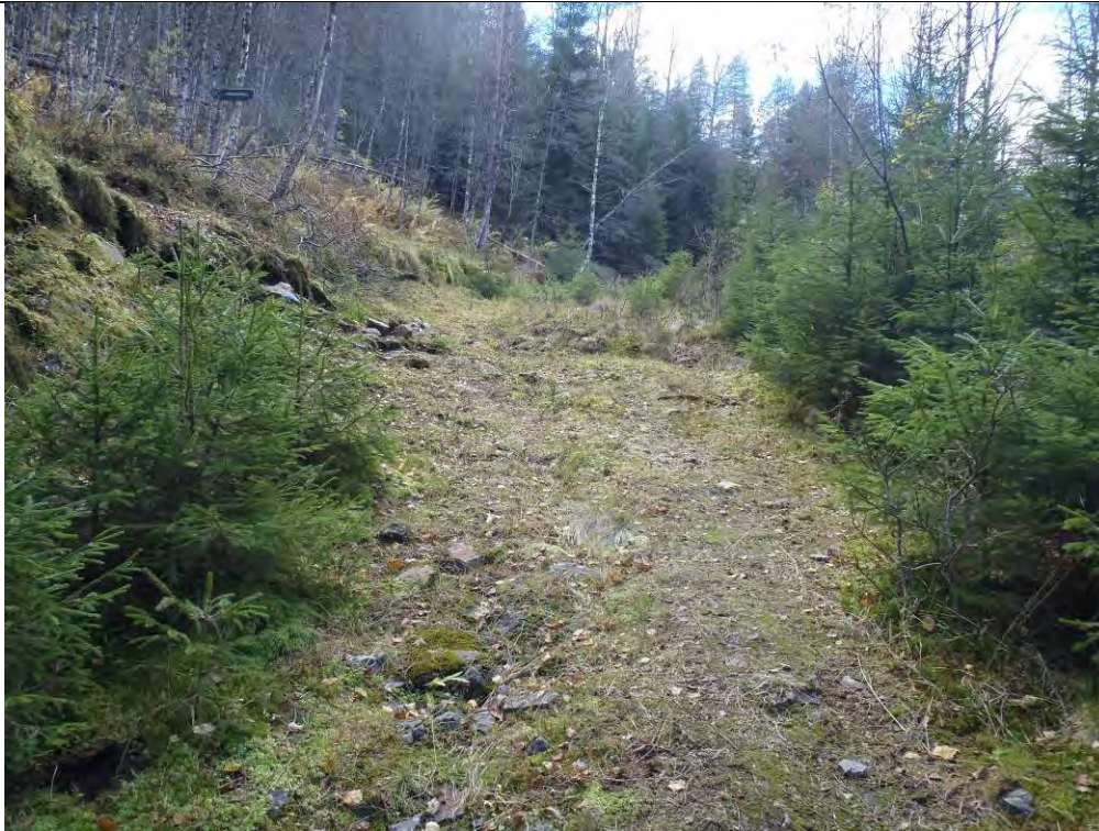
Foto 5: Nedre del av røytrase, like ovafor kraftstasjoen. Viser eksisterande traktorveg.
