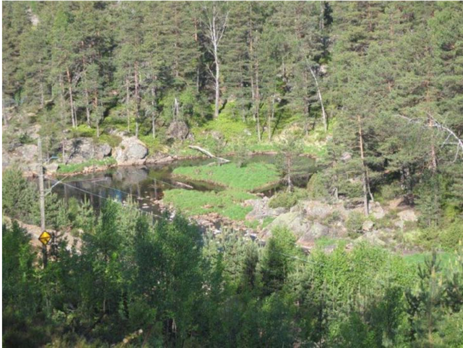
Figur 5.1: Oversiktsbilde, kulp tenkt brukt som inntaksmagasin. Terskel bygges i framkant av kulpen.
