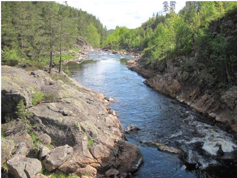
Figur 5.2: Oversiktsbilde, kulp tenkt brukt som inntaksmagasin. Terskel bygges i framkant av kulpen.
