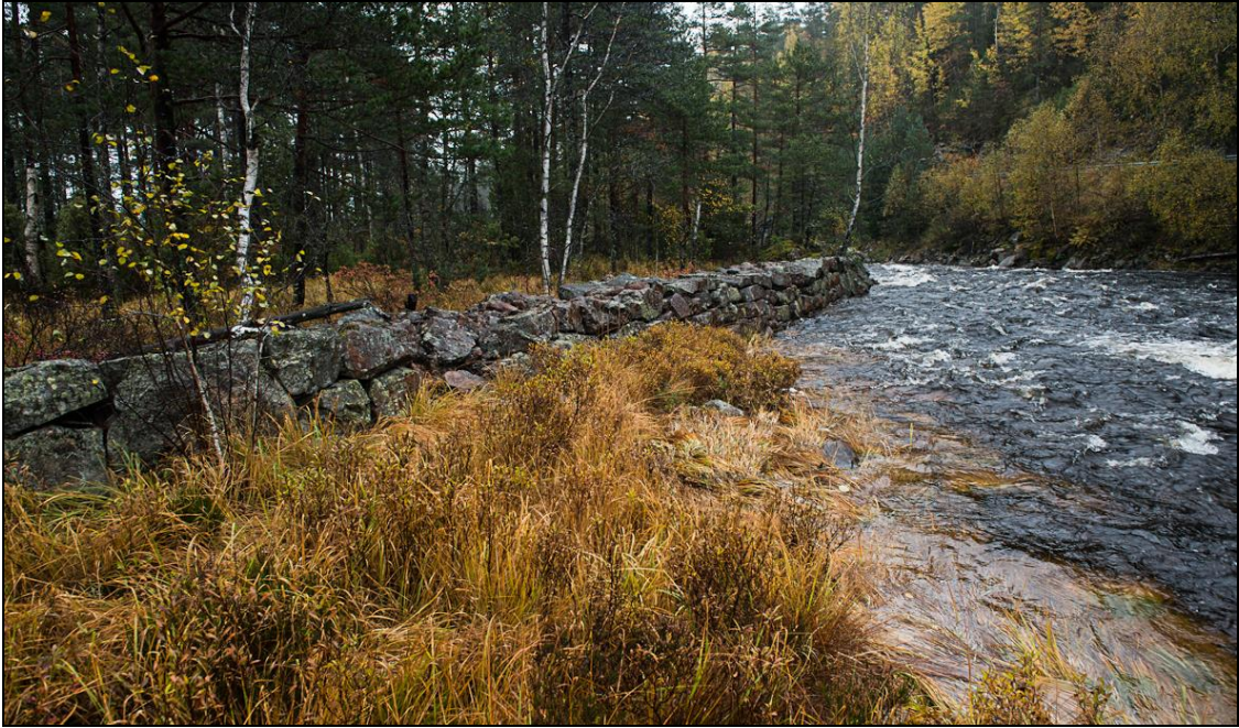
Figur 8. Menneskelig påvirkning i vassdraget. Veien kan skimtes på motsatt side av elva, mens det i forgrunnen er konstruert en forstøtningsmur. Foto: Roy Mangersnes
