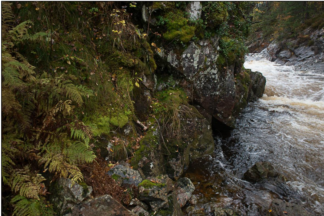
Figur 10. Fuktig parti under jernbanebrua. Foto: Roy Mangersnes
