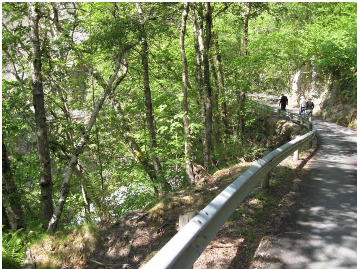
Figur 5.6: Vei og bru over Bjerga
