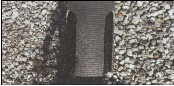
Figur 221. Splitt i nedre del av åleleder (t.v.) og forslag til utforming av luke for kontroll av åleleder (fra Anon. 1995).
