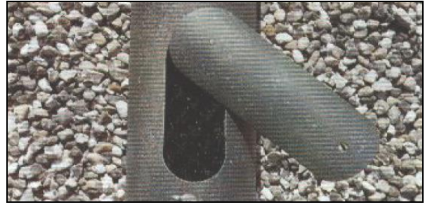
Figur 221. Splitt i nedre del av åleleder (t.v.) og forslag til utforming av luke for kontroll av åleleder (fra Anon. 1995).
