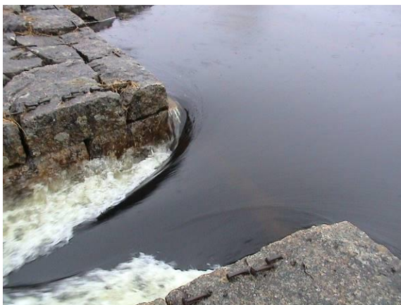
Bilde 2.6 Detalj av østre løp - Laksefossen
