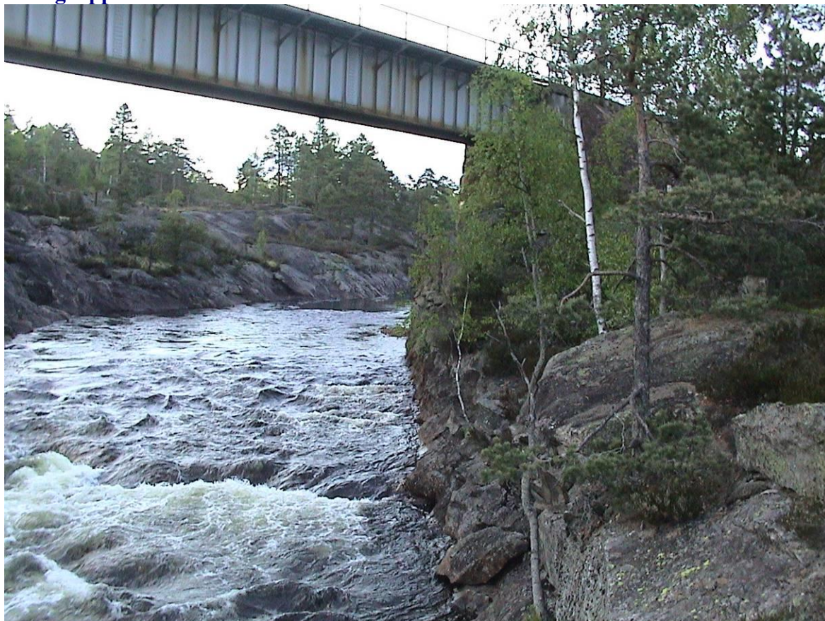
Bilde 1.1 Sett opp mot inntaket
