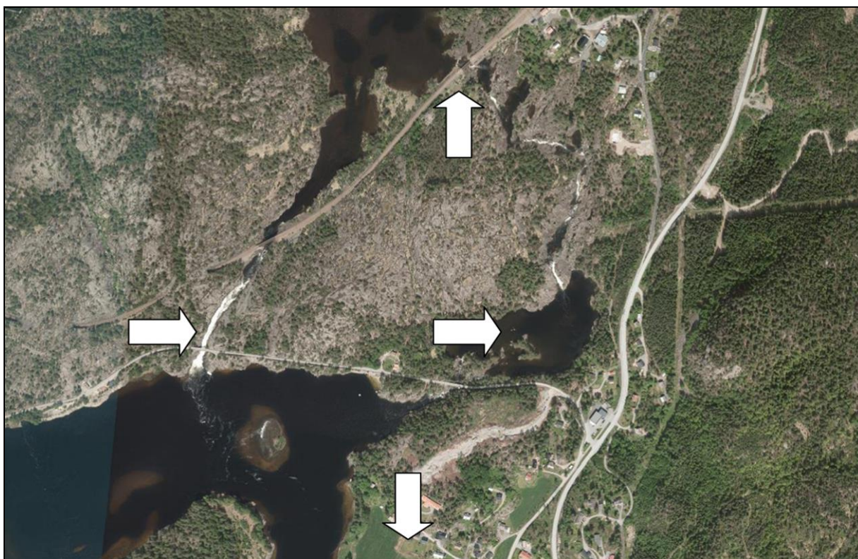
Figur 18. Flyfoto som viser Herefossen med utvidet/senket elveløp til venstre og det opprinnelige løpet via Laksefossen og Lakshøl til høyre. Dyrket mark nederst på bildet vil bli berørt av jordkabeltrasé for nettilknytning. Herefoss jernbanestasjon ligger i øvre billedkant (kilde: http://www.hvor.no/ ).
