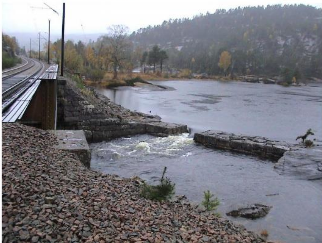
Bilde 2.5 Østre løp sett fra jernbanebro
