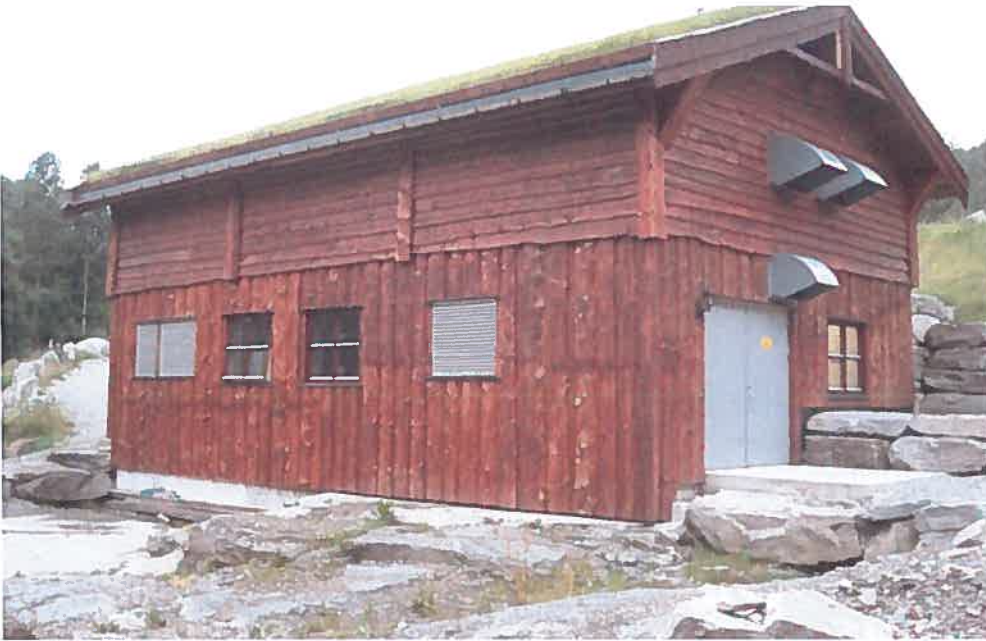
Figur 17. Kraftstasjonsbygning blir i prinsippet som på bildet. (Dette er fra byggingen av Nørståe kraftverk i Veggli. Bygget fikk byggeskikkprisen i Rollag kommune i 2008.)
