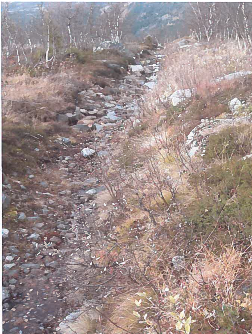
Figur 5 Dagens kanalisering på ca. kote 970 for alpinløypa inn til Bjønnebekk.
