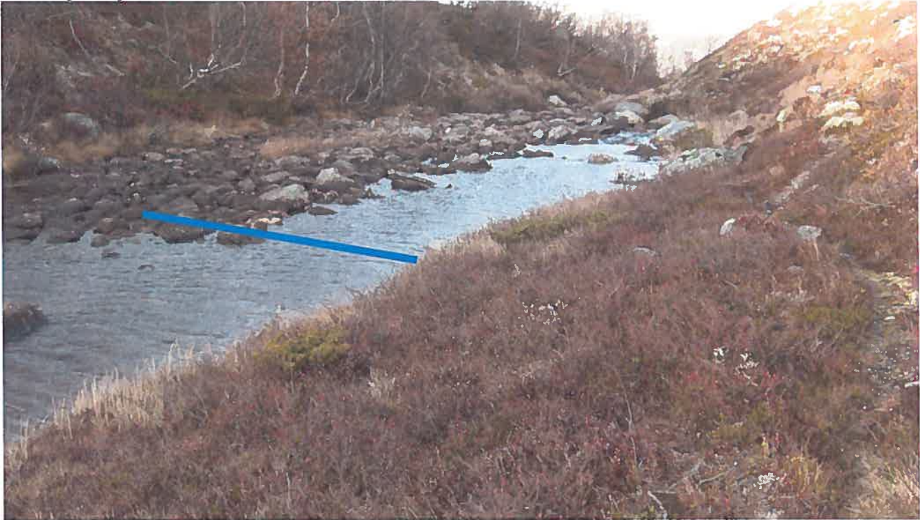
Figur 13. Fra utløpet av Nedre Bjønnetjønn. Rør kommer opp i bakkant av bildet mot inntegnet propp i tre eller betong. Propp er visualisert i bildet med blå strek, og blir liggende i flukt med vannflaten og steinene på bildet.
