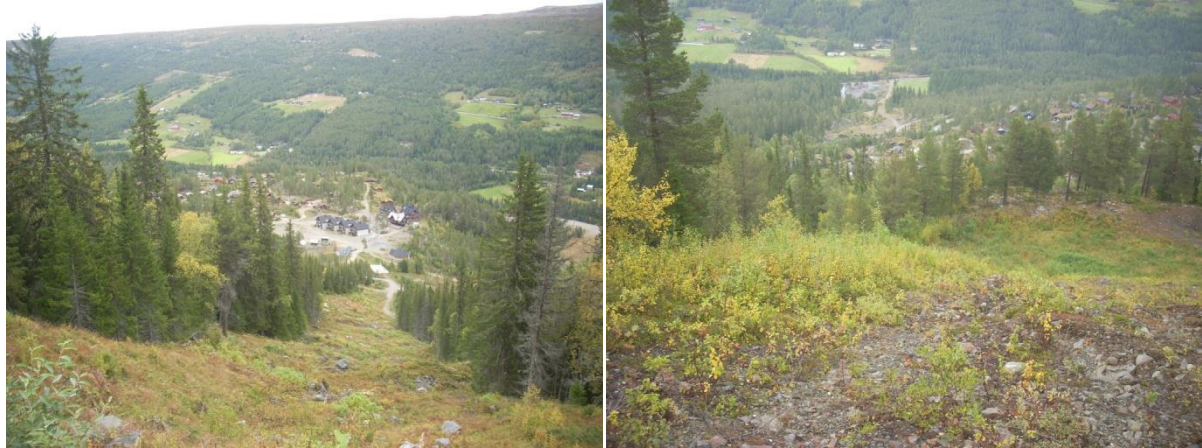
Figur 9: Viser nedre del av østligste skinedfart fra kote 800 ned mot hyttefelt (venstre), samt kort parti av vestligste nedfart få meter øst for Bjørnebekk, fra kote 860 retning nedstrøms mot hyttefelt (høyre).
