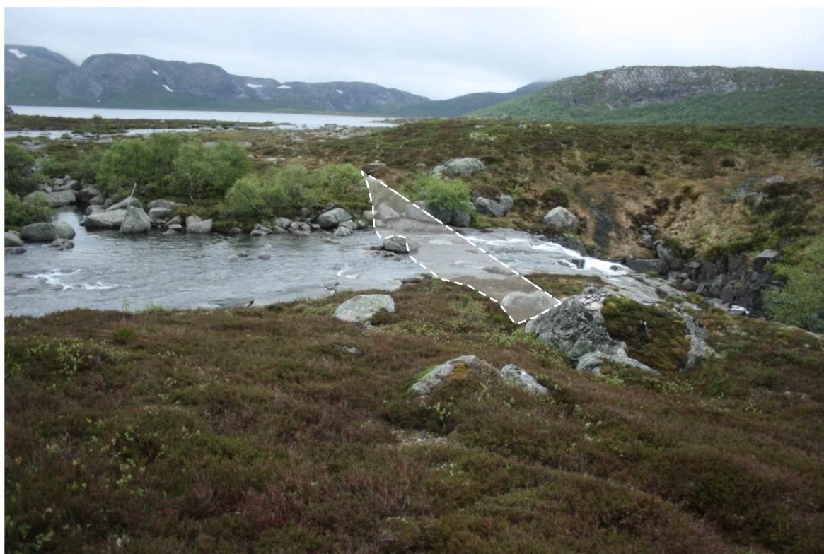
Bilde 2.2 Dam på denne fjellterskelen som indikert
