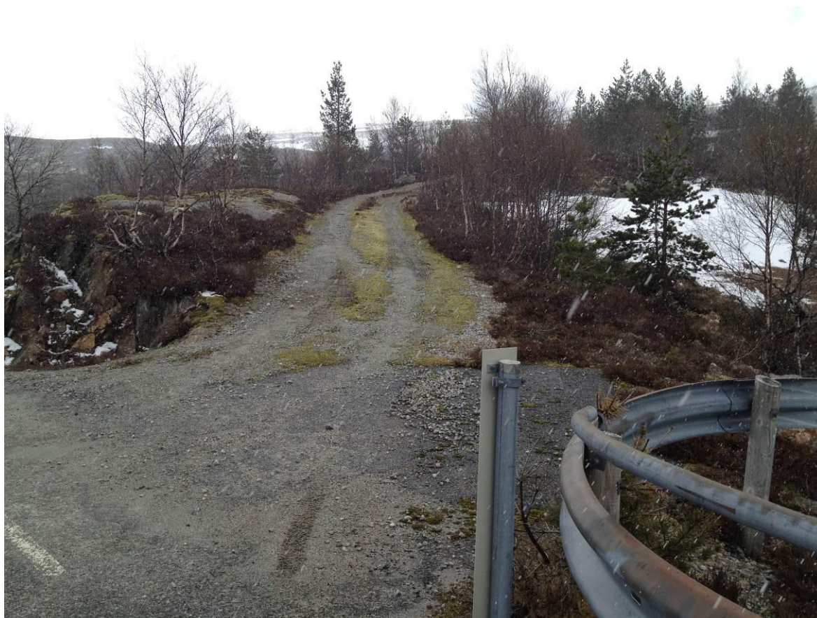
Bilde 1.2 Eksisterende avkjøring ved brua
