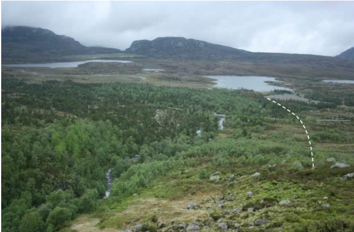
Figur 3 - Vannvei med nedgravd rør som indikert frem til område for tunellpåkugg og riggområde. Det er planlagt permanent vei som slynger seg oppover i lia langs rørgata. Bildet er hentet fra konsesjonsøknaden.
