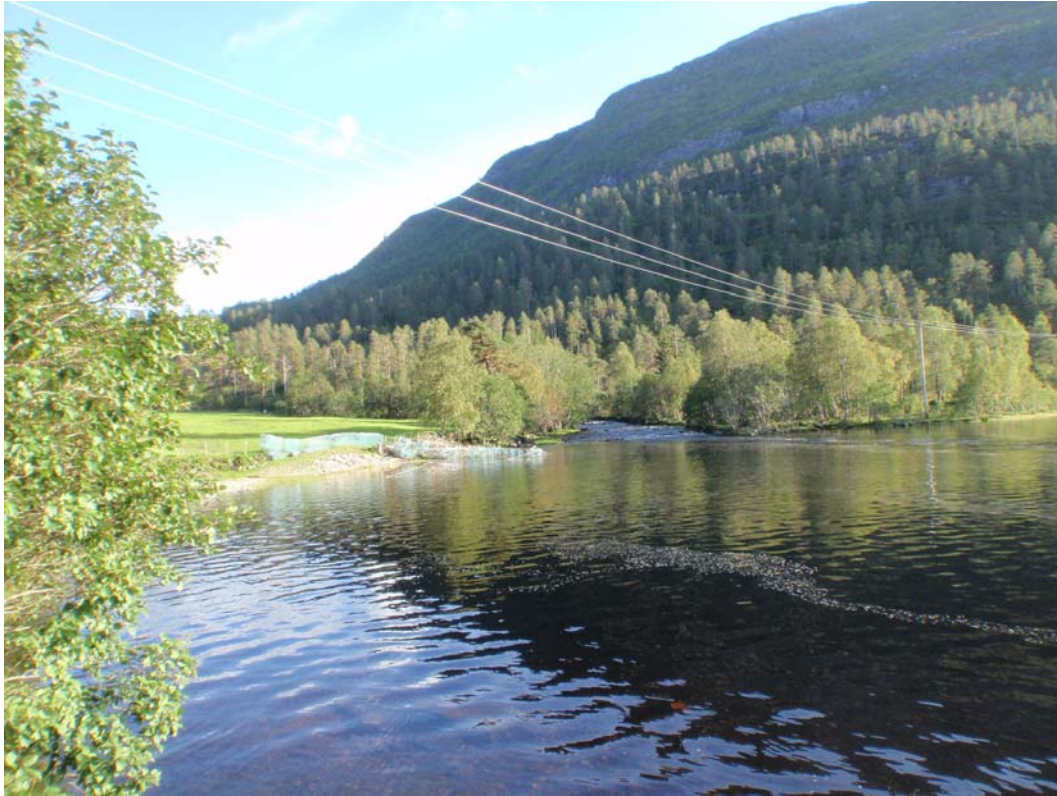
Fig.18: Bilde frå kraftstasjonsområde. Kraftverksbygningen vil ligge bak furua midt i biletet.
