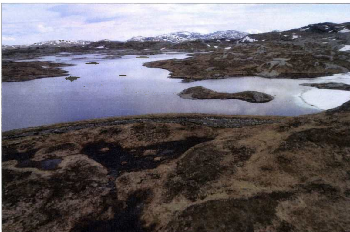
Fig. 24. Utsikt over Krossatjørnane med eldre damanlegg i forgrunnen. Foto fra tiltakshaver (høst 2012).
