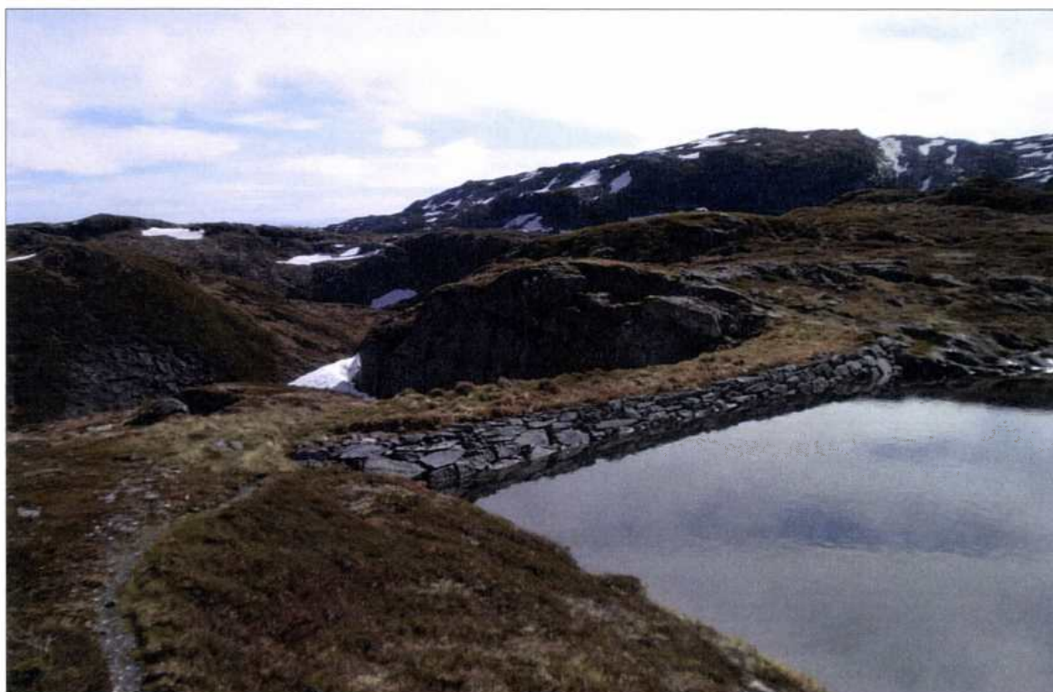
Fig. 22. Det finnes eldre damanlegg ved utløpet av Krossatjørnane. Foto fra tiltakshaver høst 2012.
