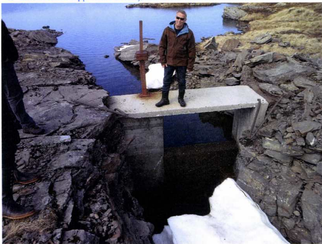
8. Eksisterande tappeluks i Krosstjørnane mot Svartavatnet i aust.
