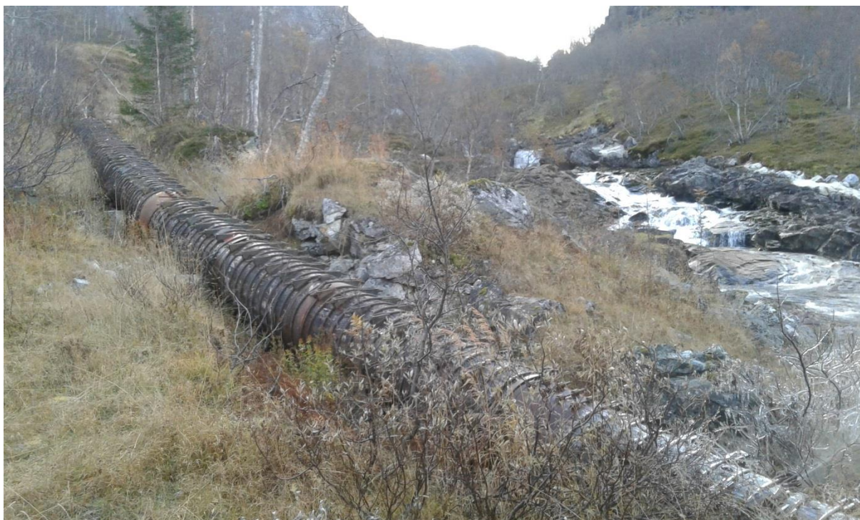
Bilde 15: Typisk bilde i røyrгатetraseen. ny røyrgate skal gravast ned.
