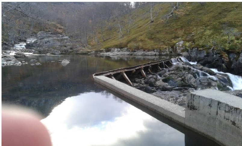
Bilde 11: Dagens demning. Denne skal fornyast, men med same dimensjoner
